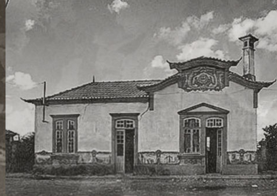
ESTAÇÃO DE SENDIM
