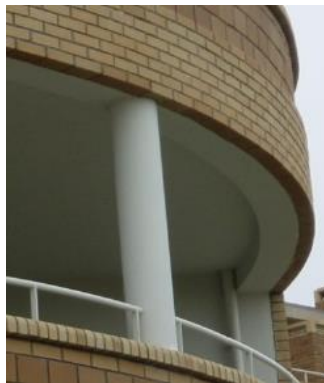
Figura 1.9. Viga com desenvolvimento curvo em planta [3]
