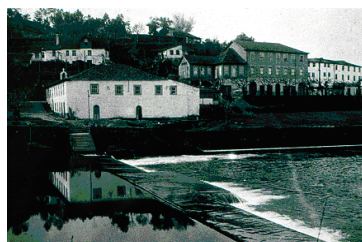
Figura 4.41 - Alçado norte da escola primária no antigo Balneário Romano sem a ampliação (Frade, 1990).
