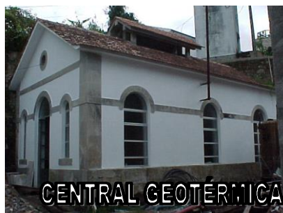
Figura 3.34 - Central Geotérmica do Campo Hidromineral e Geotérmico de São Pedro do Sul (Ferreira Gomes, 2013)
