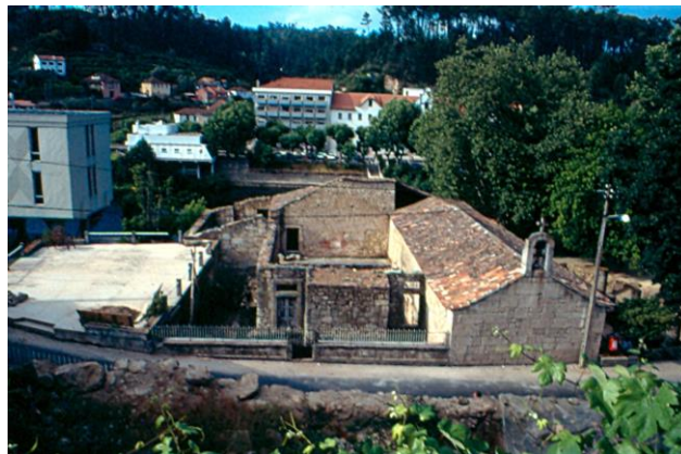
Figura 4.10 - Reservatório com cobertura em betão, junto às ruínas do balneário Romano (Frade, 1990).
