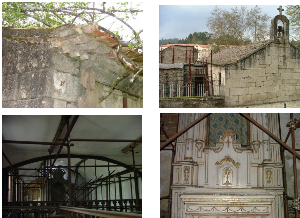
Figura 4.26 - Capela de Nossa Senhora da Saúde: interrupção do beiral, alçado da Rua Principal, coro e altar no interior (CMSPSul, 2004).
