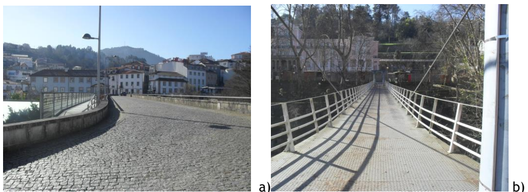
Figura 3.9 - Imagens das pontes que ligam as duas margens do Rio Vouga junto às Termas: a) Ponte rodoviária em pedra com recente ponte pedonal associada, e b) ponte metálica pedonal em frente ao Hotel INATEL Palace.
