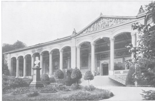
Figura 2.12 - Trinkhalle, Baden-Baden (Hübsch, 1840, in Providência, 2007).
