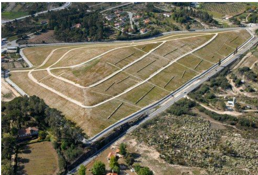
Figura 14 - Área da Barragem Velha após a conclusão dos trabalhos de recuperação (34).
