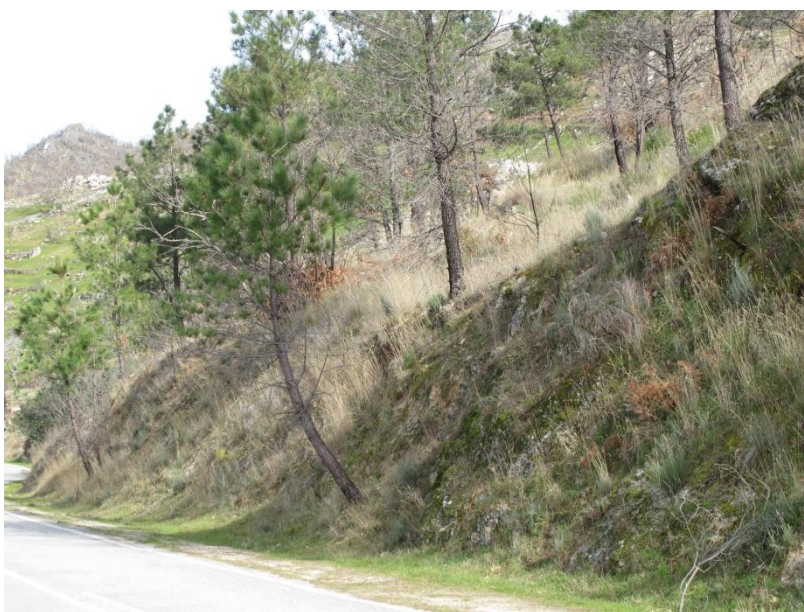
Figura 18 - Vista de uma escombrela da Mina da Carrasca, onde se evidenciam processos de “Creeping”.
