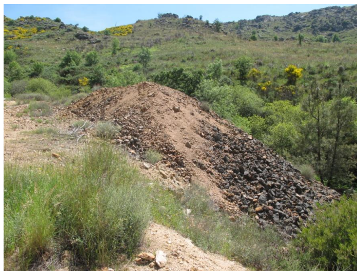
Figura 37 - Escombrelira da Mina de Vale d'Arca com sinais de instabilidade no talude.
