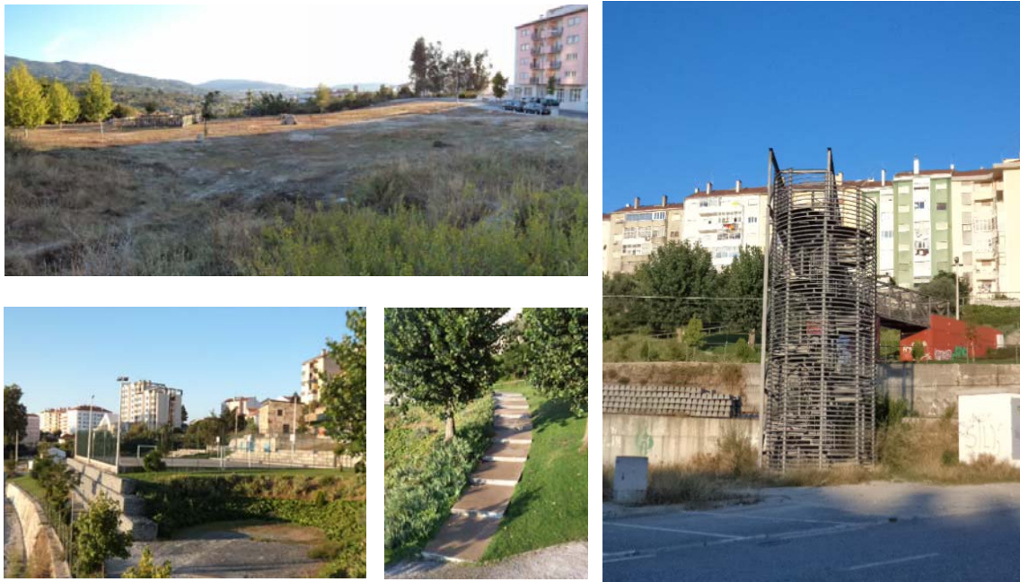
Imagem 40 - Áreas de cedência no loteamento nº 20 com a implementação de equipamentos públicos no âmbito do Programa Polis (imagens direita e inferiores), a restante área verde fora deste programa encontra-se vazia de uso (imagem superior esquerda).
