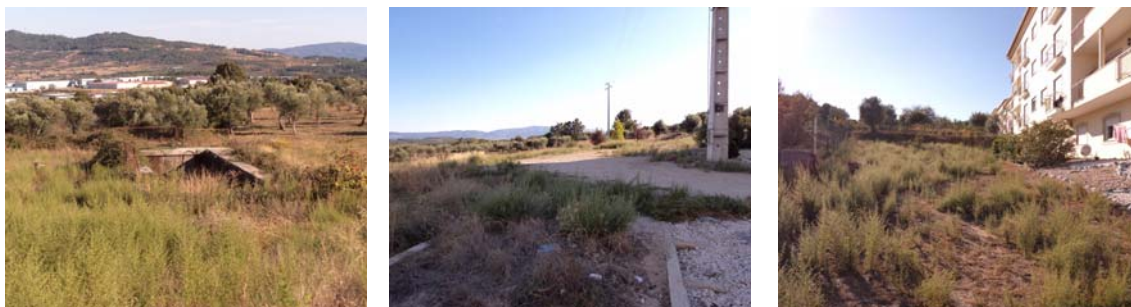
Imagem 24 - Zona de cedência do loteamento nº 12 sem qualquer utilização (foto superior). Áreas de cedência destinadas a zonas verdes sem manutenção e apresentam densa vegetação (fotos inferior)
