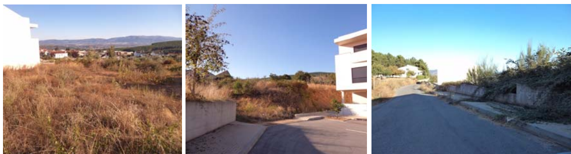
Imagem 66 - Zona de cedência destinada a equipamento de utilização colectiva no loteamento nº 33 com densa vegetação
