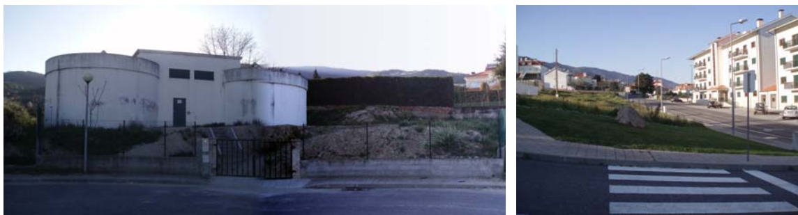
Imagem 68 - Zona de cedência utilizada para instalação de depósito de água para abastecimento público e zona verde pública no loteamento nº 34
