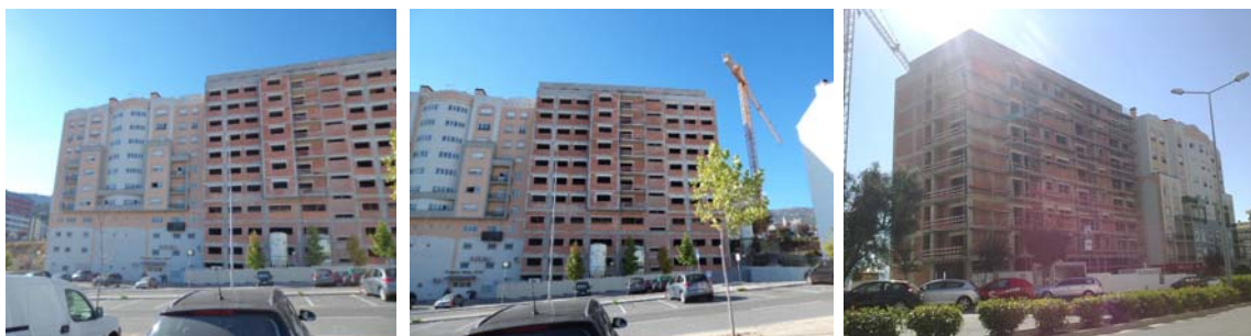
Imagem 80 - Vista geral do loteamento apenas com zona verde pública na envolvente dos lotes
