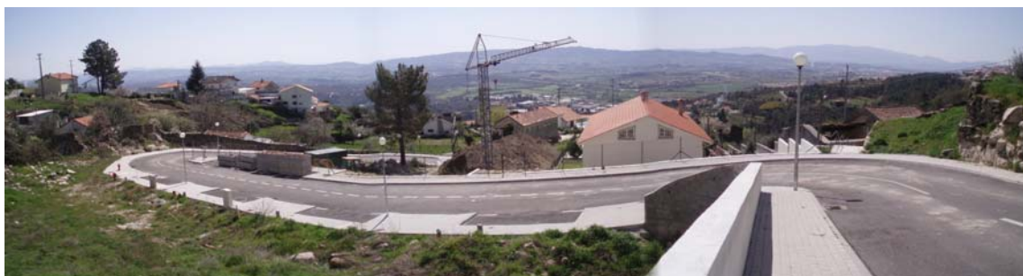
Imagem 82 - Vista geral do arruamento que serve o loteamento nº 41
