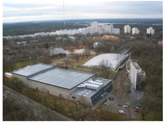
Imagem 11 - Vista sobre elevada dos equipamentos existentes
