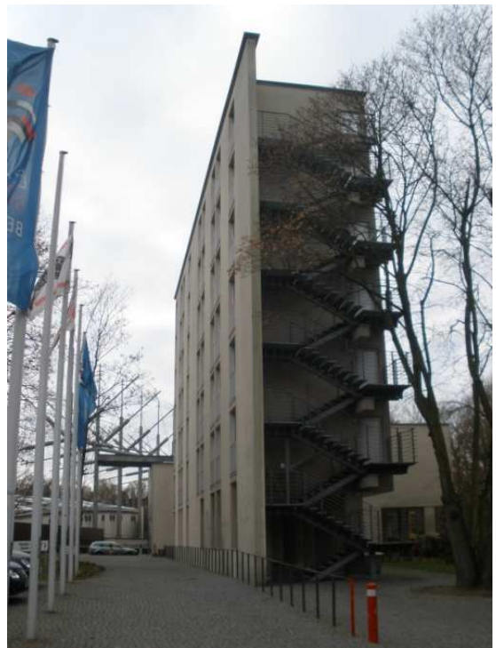
Imagem 12 - hotel desportivo existente
