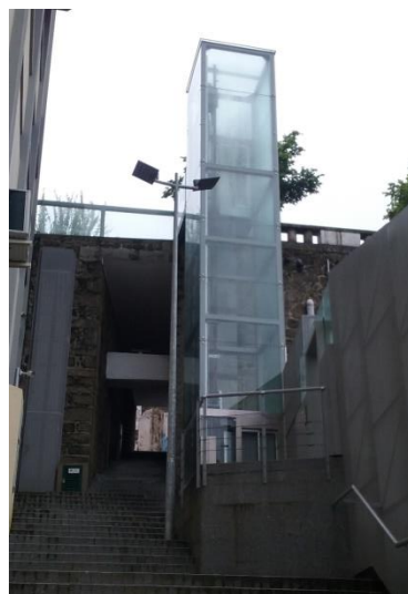
Ilustração 36 - Paragem superior do Funicular de São João e elevador vertical que faz o complemento do percurso para o Largo das Forças Armadas (Covilhã).
