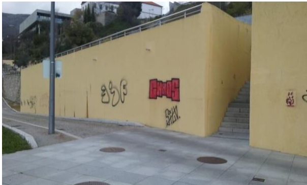
Ilustração 22 - Escada, no Parque da Goldra na Covilhã, que sai diretamente na rua, sem visibilidade para o automobilista, nem para o peão.
