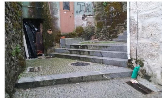
Ilustração 75 - Escada na Rua das Flores (Covilhã).
