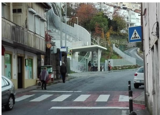
Ilustração 39 - Nas proximidades do Funicular de São João, na Rua Mateus Fernandes, na Covilhã, a passadeira mal posicionada, passeio estreito, interrompido e obstruído por garrafas de gás do comércio vizinho.
