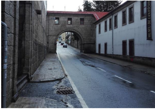
Ilustração 108 - Arco em granito sobre a Rua Marquês D'Ávila e Bolama, na Covilhã.
