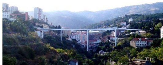
Ilustração 51 - Ponte da Carpinteira, sobre o vale de mesmo nome (Covilhã).
