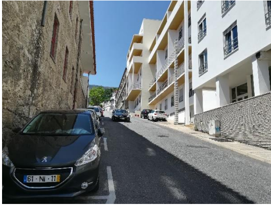
Ilustração 77 - Falta de passeio no lado que faz sombra a tarde, na Calçada Fonte do Lameiro na Covilhã.
