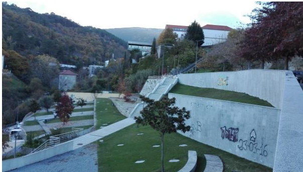
Ilustração 20 - Patamares abaixo do Elevador da Goldra e escadas, na Covilhã.
