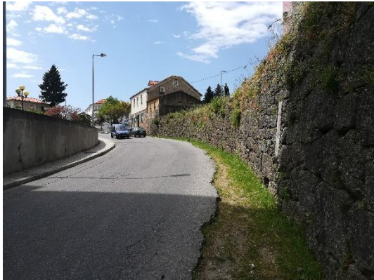
Ilustração 73 - Rua de Acesso à Estação (Covilhã), sem calçada para o peão.
