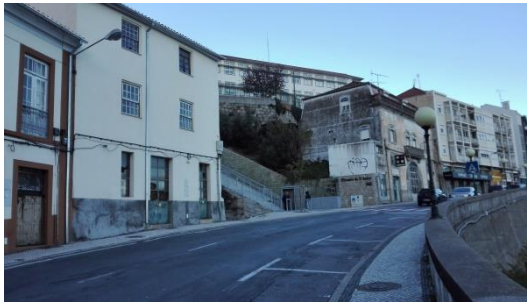
Ilustração 30 - Os dois edifícios mais próximos do Elevador de Santo André (Covilhã), encontram-se deteriorados e sem uso comercial no rés-do-chão.
