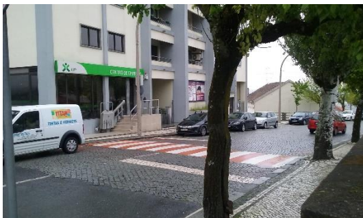
Ilustração 88 - Na Av. 25 de Abril, em frente ao Centro de Empregos (Covilhã) a passarela foi posicionada em frente a uma árvore que dificulta a acessibilidade universal.
