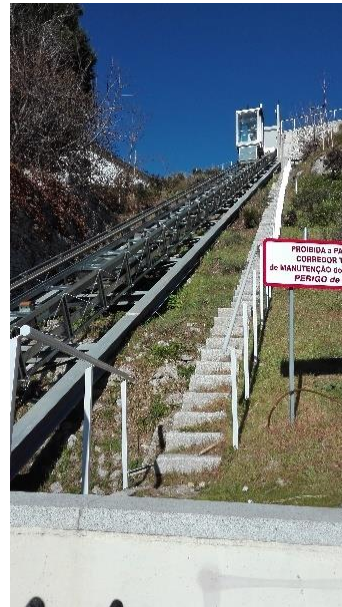
Ilustração 23 - Escada lateral ao elevador da Goldra, na Covilhã, que serve apenas para serviços técnicos, sem acesso para as utentes
