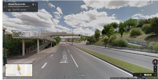
Ilustração 47 - Passadeira elevada em frente ao Centro de Saúde (Covilhã).
