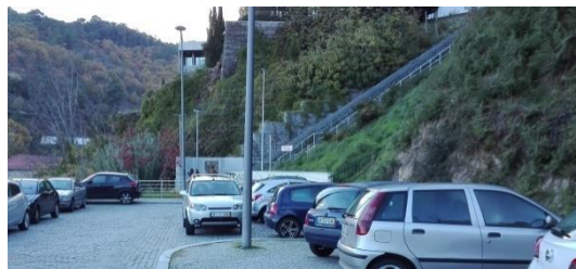
Ilustração 18 - Elevador da Goldra, que liga estacionamento acima do Parque à rua Marques D'Ávila e Bolama, na Covilhã.
