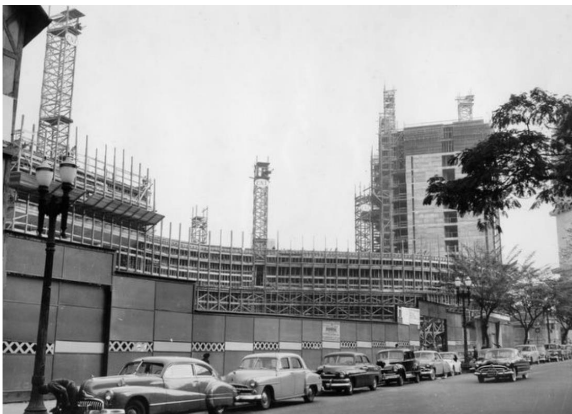
Figura 21- Início da Construção do Copan (Fonte 21)
