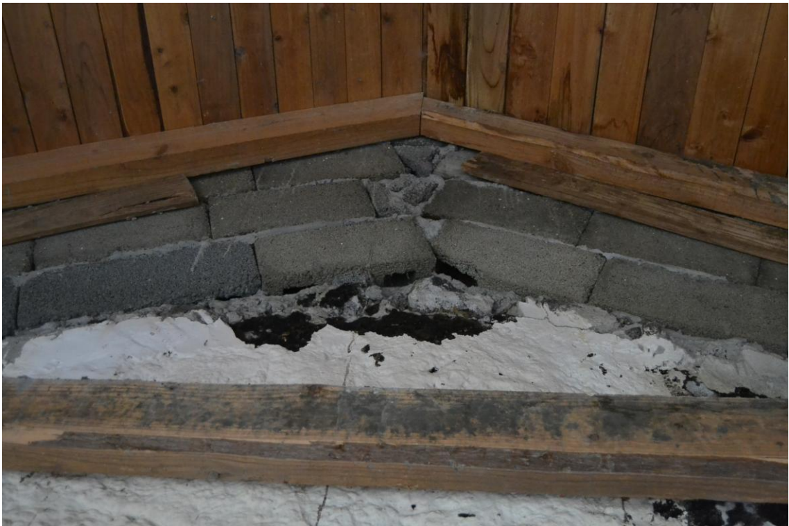
Ilustração 30. Solução empreendida para a subida da cobertura na empena da cozinha
