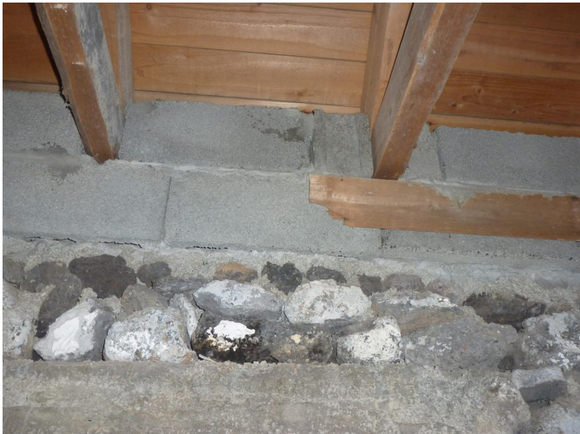
Ilustração 26. Pormenor da execução da cobertura em Criptoméria e paredes sem reboco
