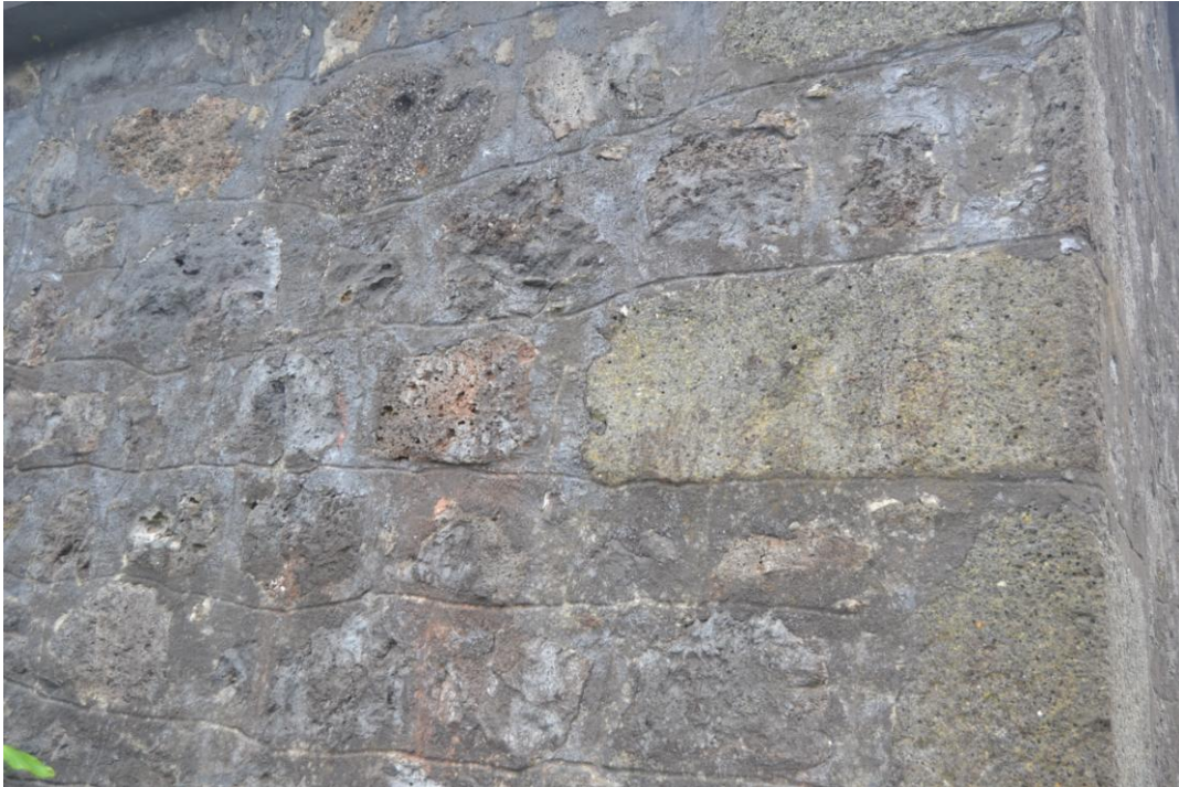
Ilustração 21. Remate da junta com argamassa de cimento e areia
