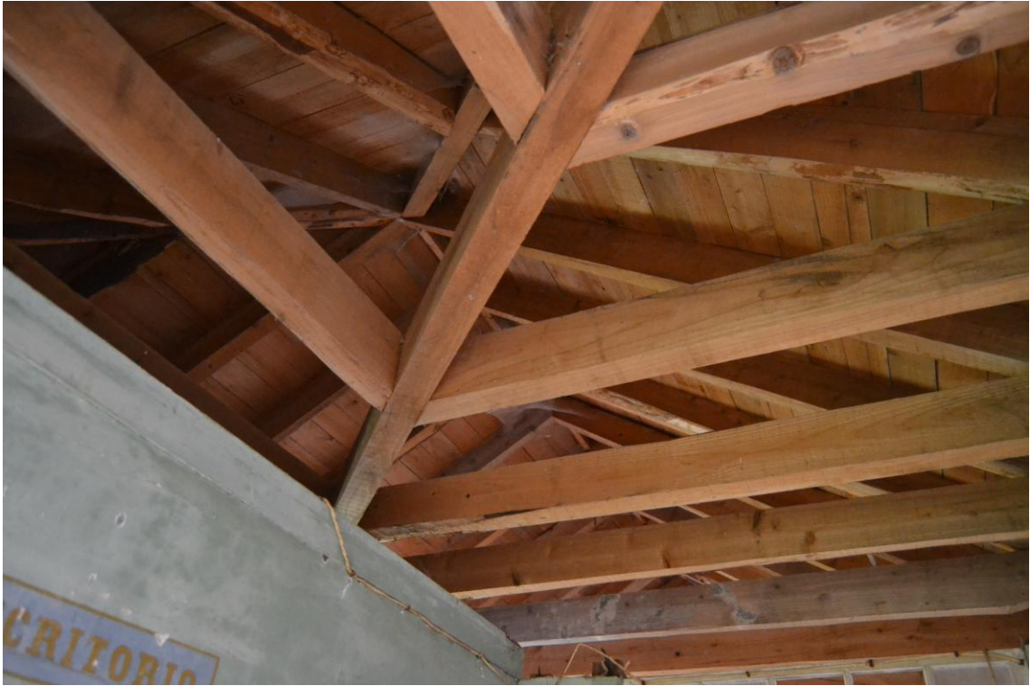
Ilustração 29. Pormenor da cobertura
