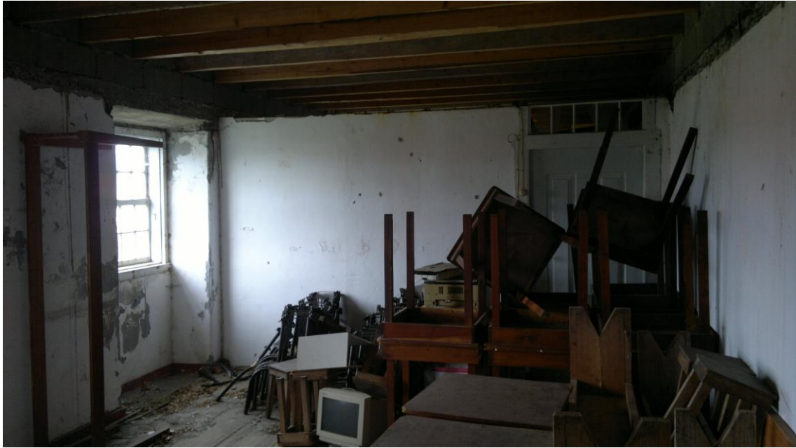
Ilustração 25. Interior do Passal, servindo de arrumos gerais
