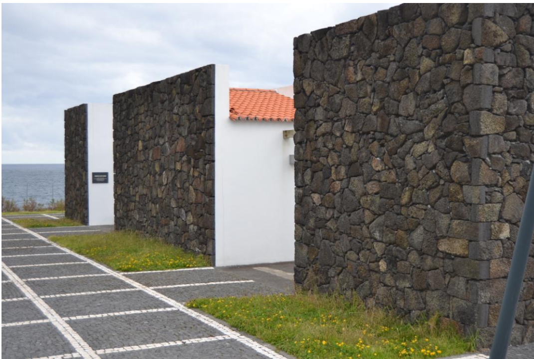
Ilustração 22. Alvenaria de pedra pelo exterior da parede e alvenaria de bloco de cimento pelo interior
