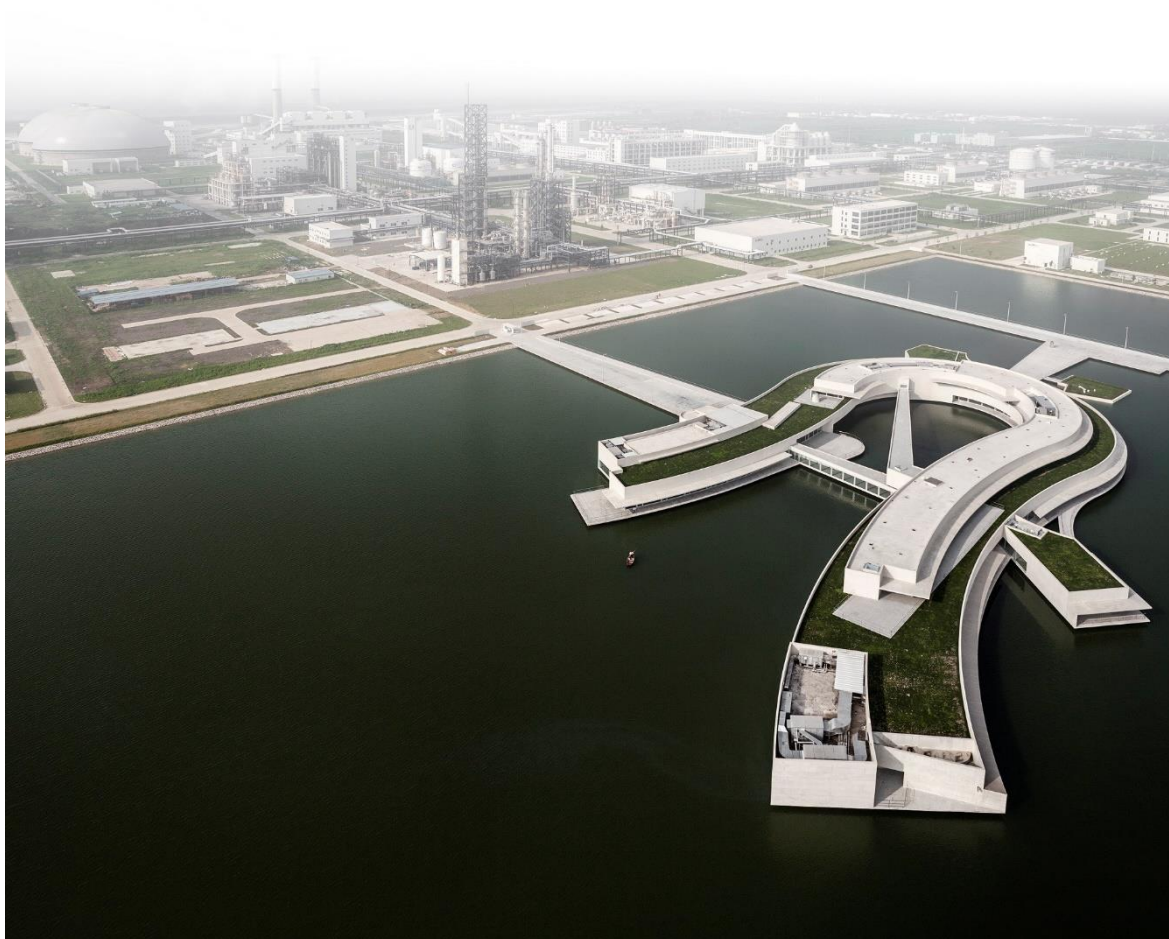
Figura 75| Edifício sobre a água, Álvaro Siza + Carlos Castanheira, China, Fernando Guerra (Archaily, 2014)
