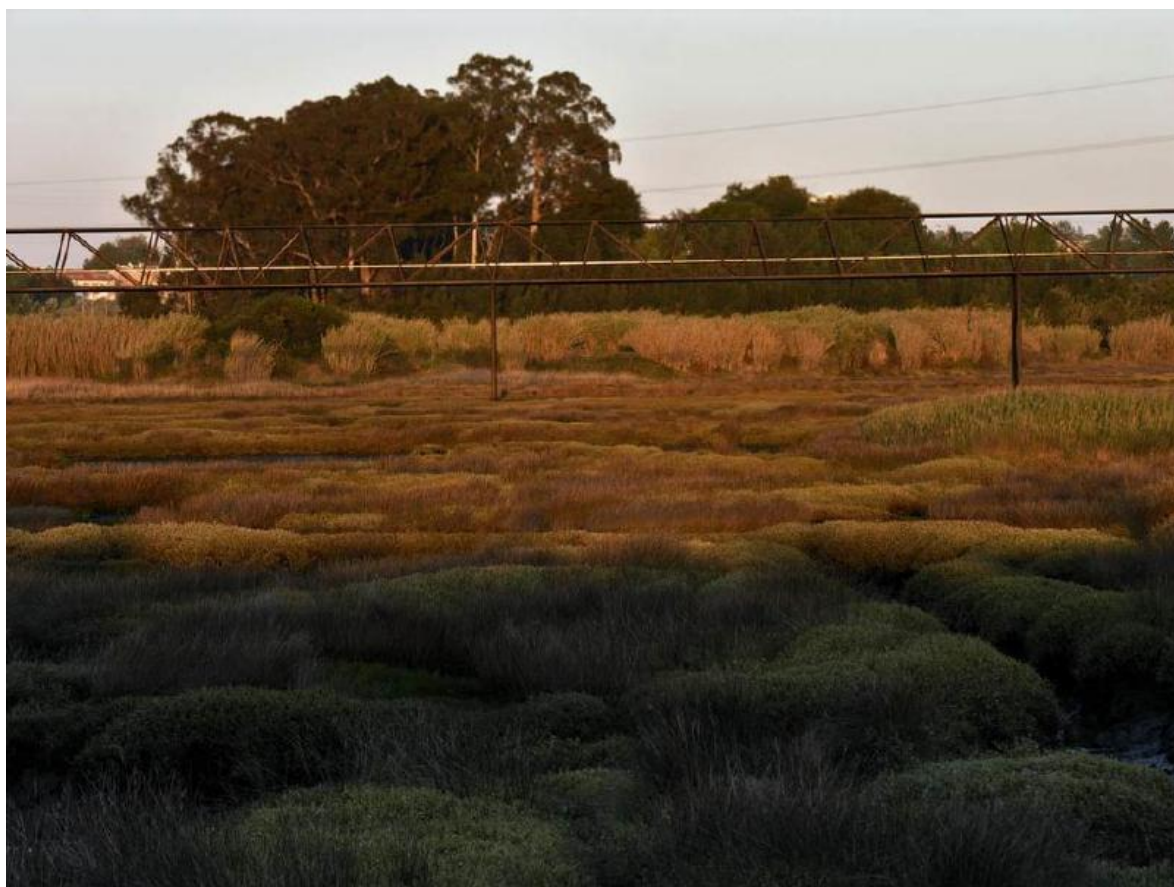
Figura 55| Ponte Pedonal sobre o Esteiro de São Pedro, Aveiro, João Luís Carrilho da Graça, 1999 (Divisare, 2006)
