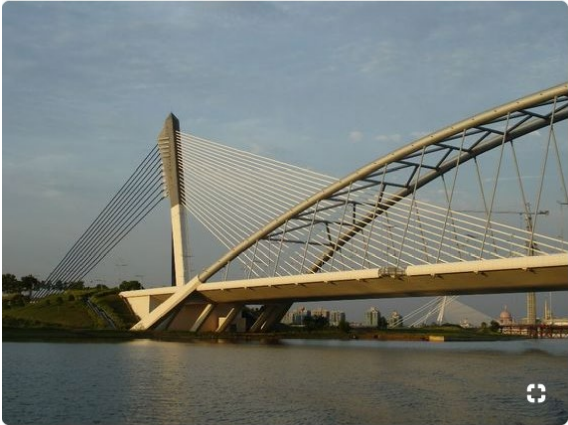
Figura 5 - Sistema cooperativo da Ponte Putrajaya, (adaptado de [12]).
