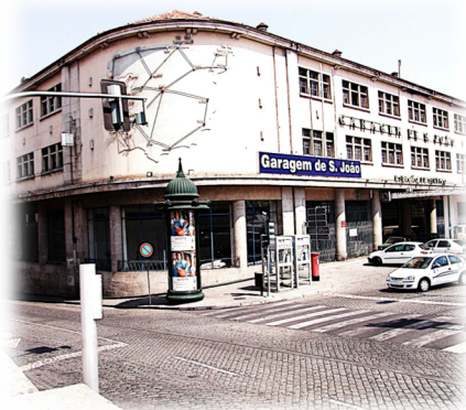
Fig. 42 - Garagem de S. João - enquanto estava operacional. Fonte: João Neves
