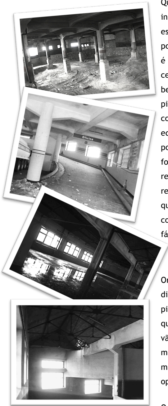
Fig. 47 - Zona da antiga estação rodoviária; Fig. 48 - A rampa que integra a estrutura; Fig. 49 - Iluminação reduzida - pisos 1 e 2; Fig. 50 - As asnas que suportam o telhado; Fotos de autor. 2012
