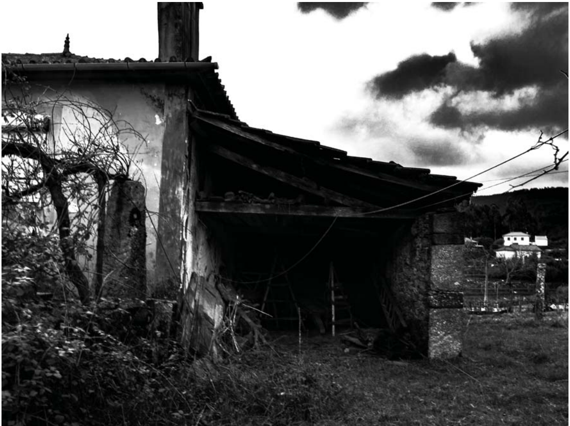
Figura 3.30. Coberto da casa 1
