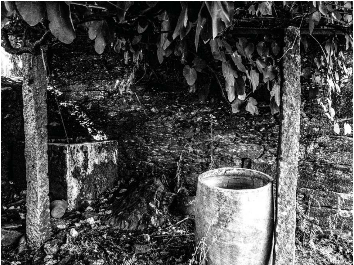
Figura 3.26. Parede Sul da casa 2
