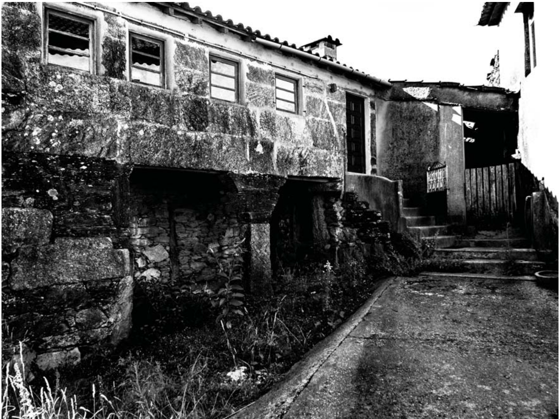
Figura 3.08. Fachada da casa
