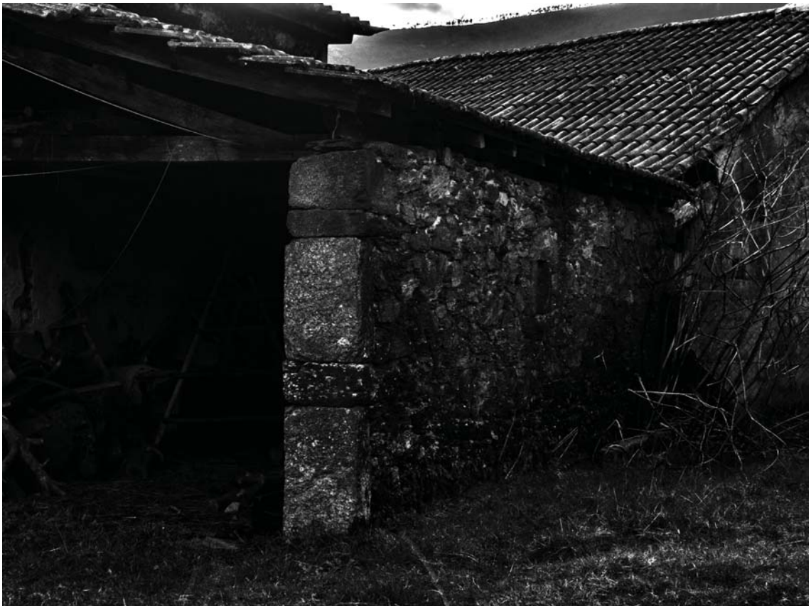
Figura 3.28. Coberto a Norte da casa 1
