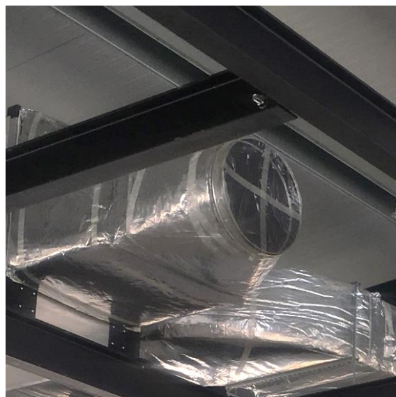
Figura 29 - Condutas tamponadas após instalação.
