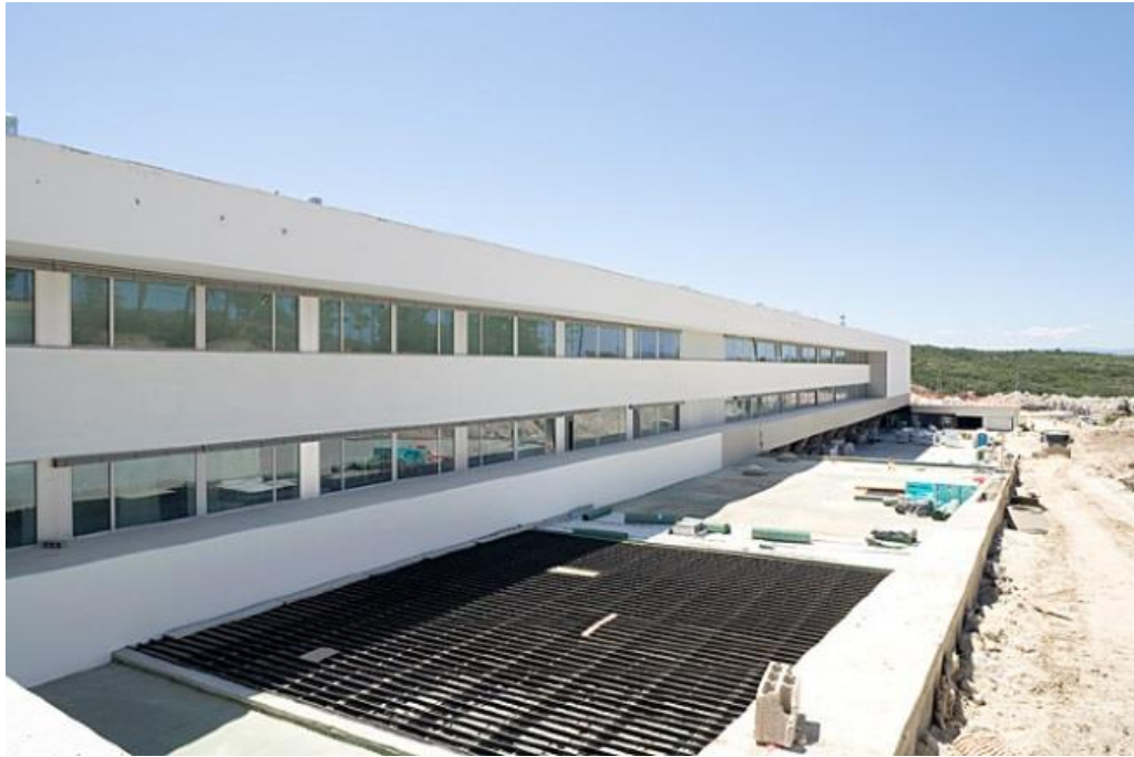
Figura 5- Remodelação do Hospital Sousa Martins, Guarda [9].
