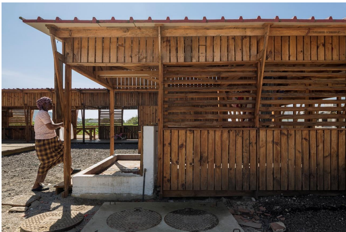
Figura 71 - Ponto de abastecimento de água.
