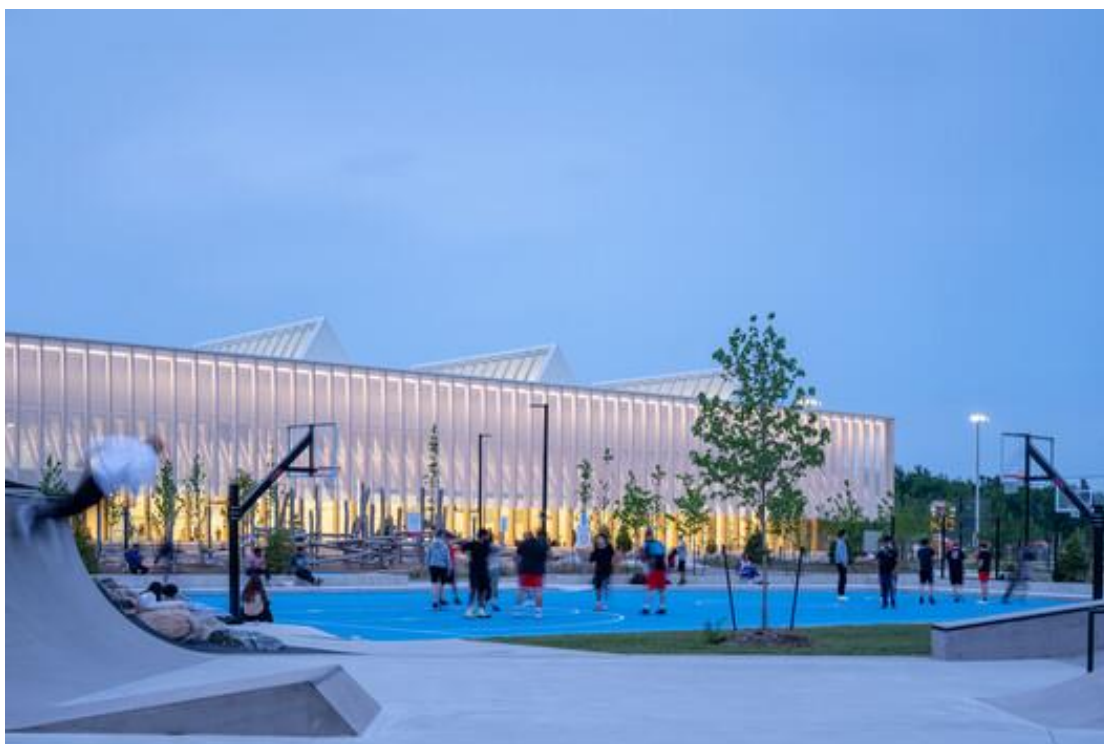
Figura 79 - Exterior do edifício do centro comunitário e alguns campos de jogos.
