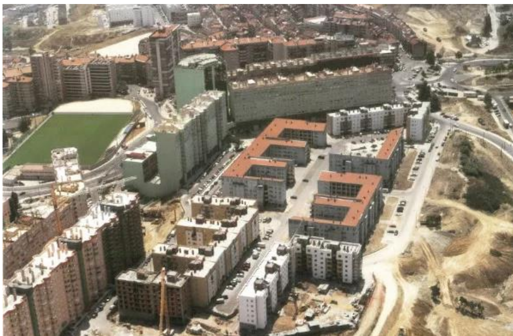
Figura 43 - O bairro das Olaias em construção, resultante de processos PER e PIMP. Na parte superior da imagem, o bairro Portugal Novo, resultante do processo SAAL.
