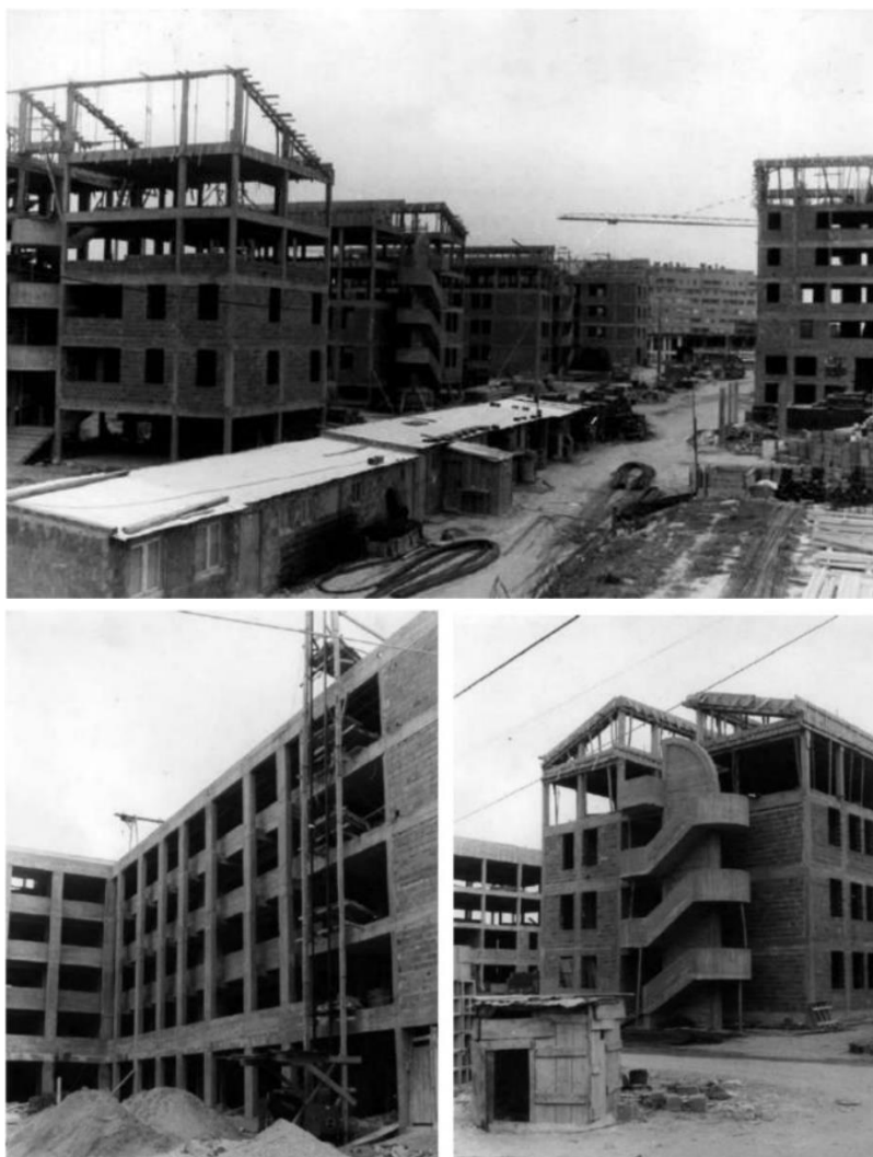
Figura 25 - Fotos do bairro Portugal Novo em construção (1983).
