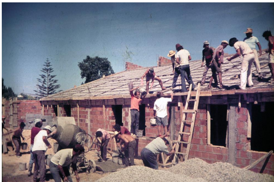
Figura 12 - Obras da operação SAAL em curso em Lagos.
