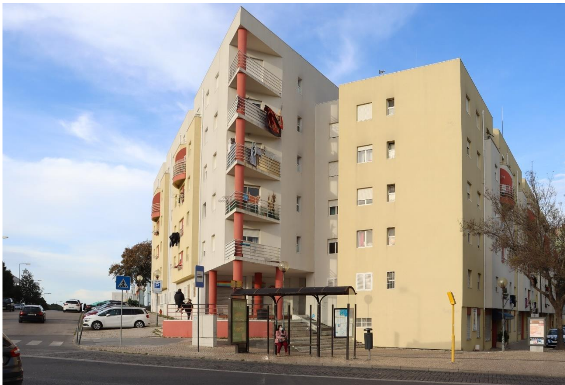
Figura 36 - A entrada mais a sul do bairro (a passagem pode não ser clara - subindo as escadas, que vemos na imagem, viramos à direita e entramos no bairro).
