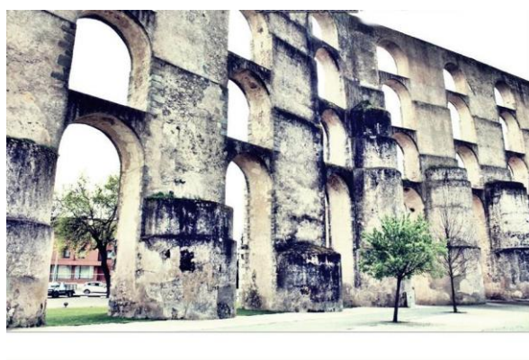
Fig. 1: Aqueduto da Amoreira
