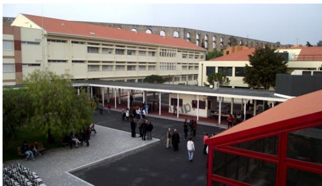
Fig. 3- Exterior da Escola Secundária D. Sancho II
