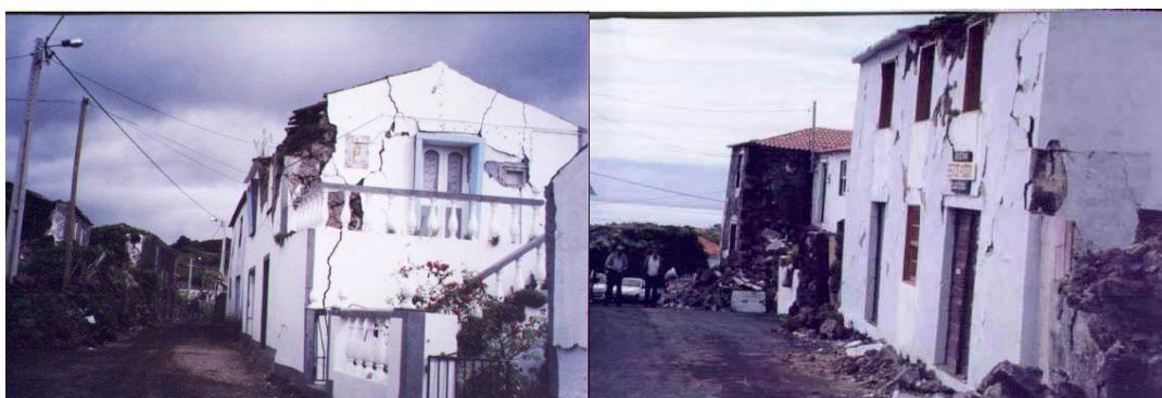
Fig. 2.1.4. – Danos em habitações na Ilha do Pico, resultantes do sismo de 9 de Julho de 1998. [5]
