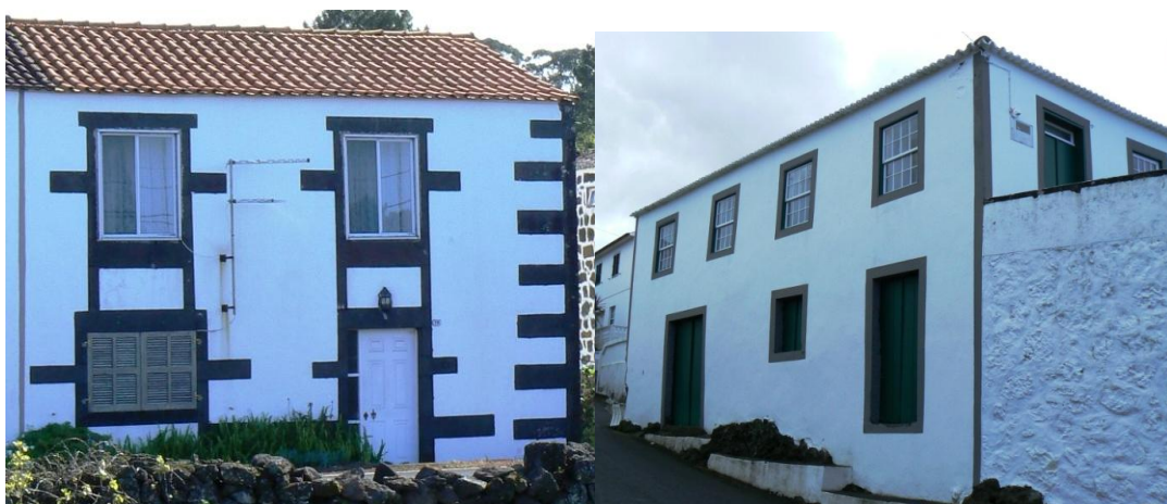
Fig. 2.4.3. – À esquerda – revestimento parcial da alvenaria, à direita – revestimento total da alvenaria
