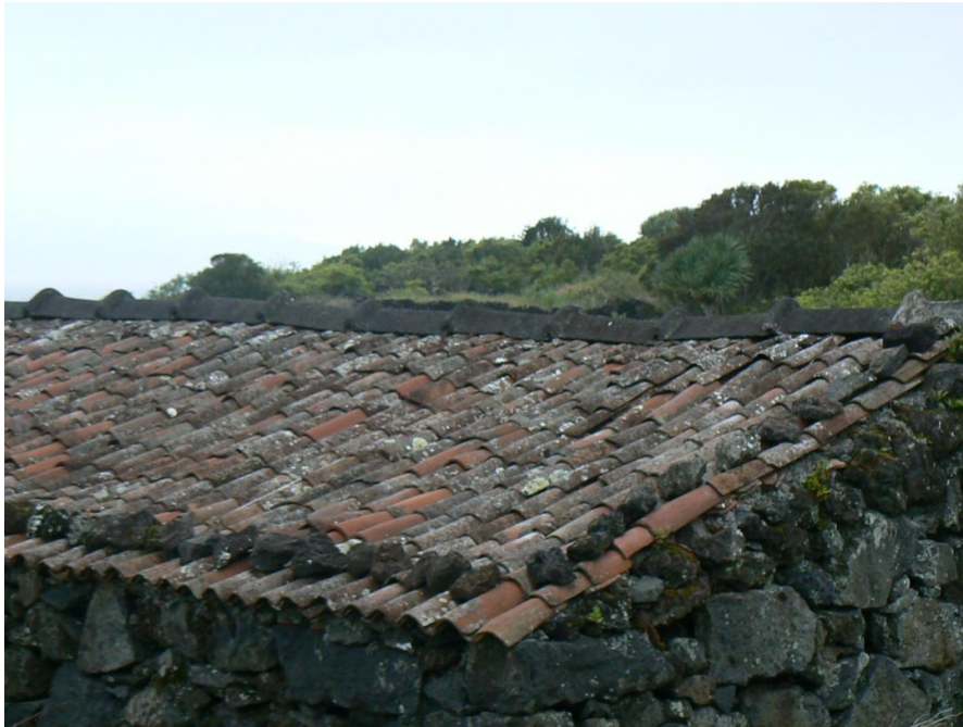
Fig. 2.4.6. – Cobertura com pedras para fixação das telhas.
