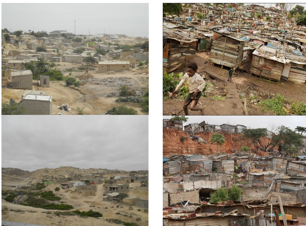
Figura 112 – Construção não consolidada em espaço urbano; A edificação normalmente é construída pelo próprio, utilizando recursos locais e localizam-se em áreas suburbanas (arqpaís, 2020)
