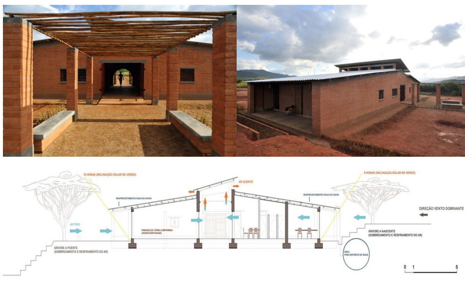
Figura 77 – Zona exterior a Norte do Centro Comunitário de Manica (ArchDaily, 2013)
