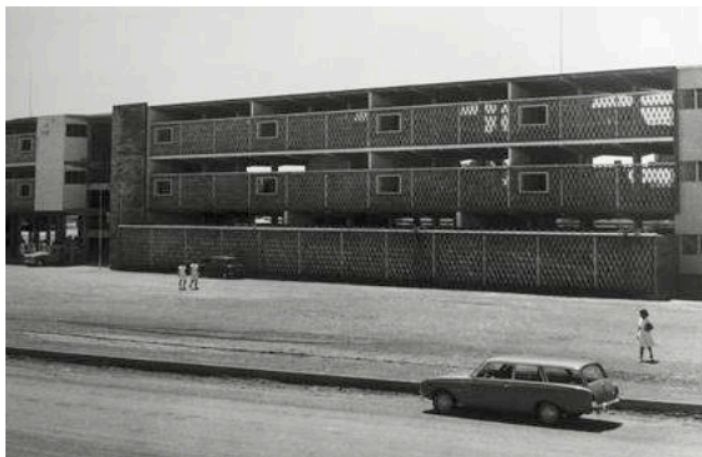
Figura 13– Fachada sombreada do Liceu do Lobito de Castro Rodrigues. Aqui a fachada sombreada cria zonas de baixa temperatura e diferente pressão que permitem arrefecer a escola, uma adaptação do edifício ao clima (Costa, 1966)
