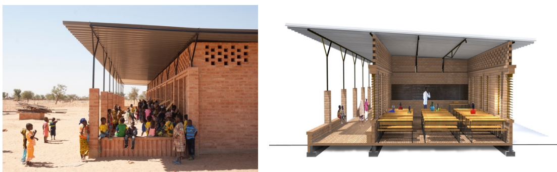
Figura 45 – Cobertura com placas de aço sobrepostas - Escola Primária Gangouroubouro, Africa do Sul (ArchDaily, 2021)
