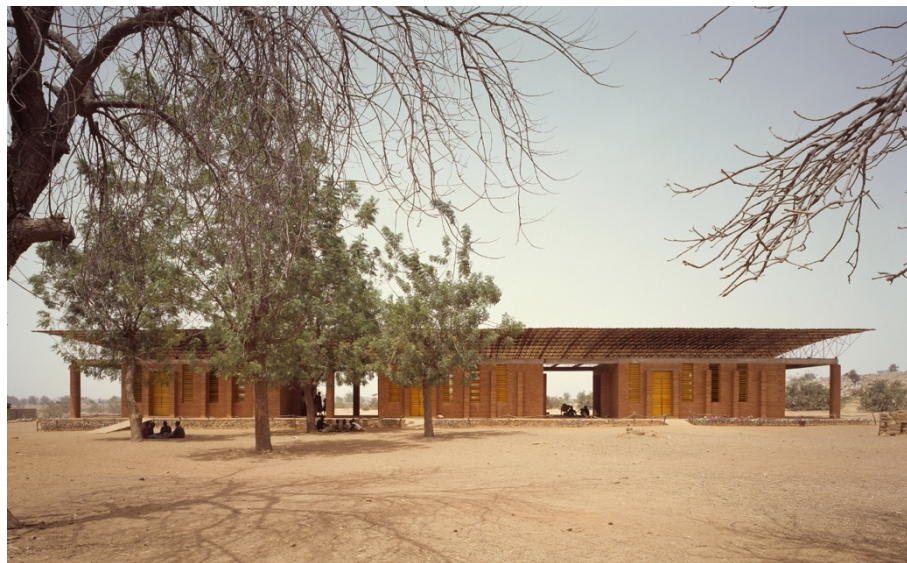
Figura 47 – Escola Primária em Gando, fachada principal (Fonte: Simeon Duchoud)
