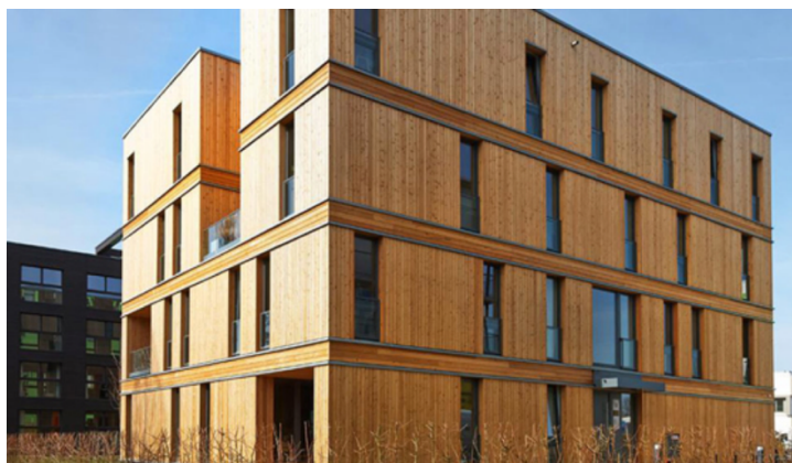
Figura 44 – Construção em madeira, painéis CLT (portal de arquitetura, 2021)
