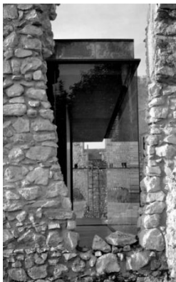
Figura 39 - João Mendes Ribeiro, A Casa de Chá , 1999. Ligeira intervenção na ruína. Fotografia de João Mendes Ribeiro, 2000.
