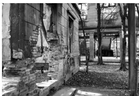
Figura 48 - Escola de Meninas em estado de ruína. Contraste entre o orgânico e o inorgânico. Fotografia de São Paulo Antiga, 2012.
