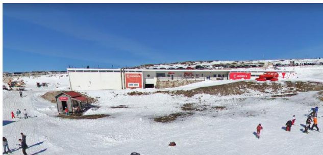
Figura 12 – Vista frontal do Edifício de Apoio, Vodafone
