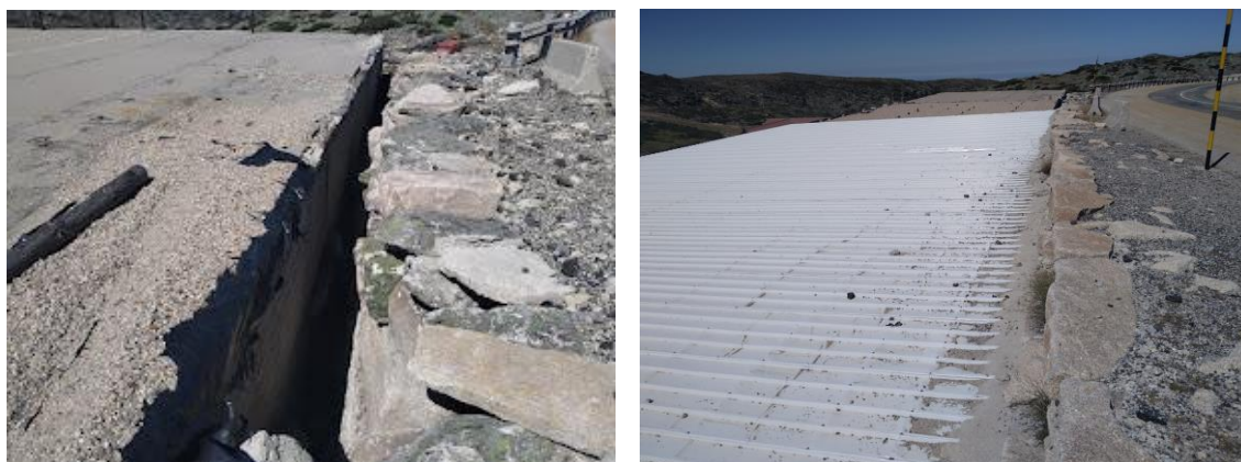
Figura 21 e 22 – Estado atual da Cobertura do Pré-Existente
