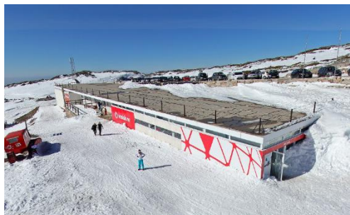
Figura 13 – Edifício de Apoio, Vodafone
