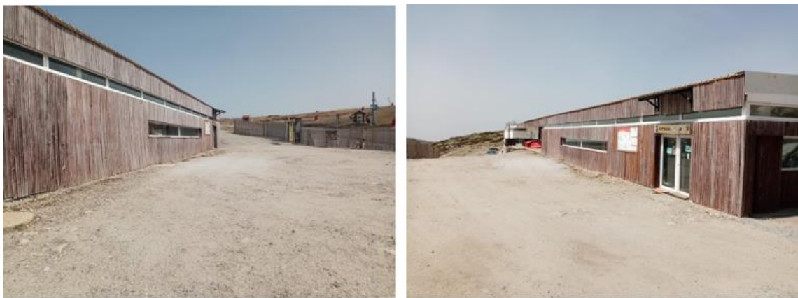
Figura 24 - Fachada Atual do Pré-Existente constante.
