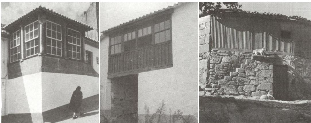
Fig. 13 - Varanda envidraçada - Guarda, coletor de energia solar
