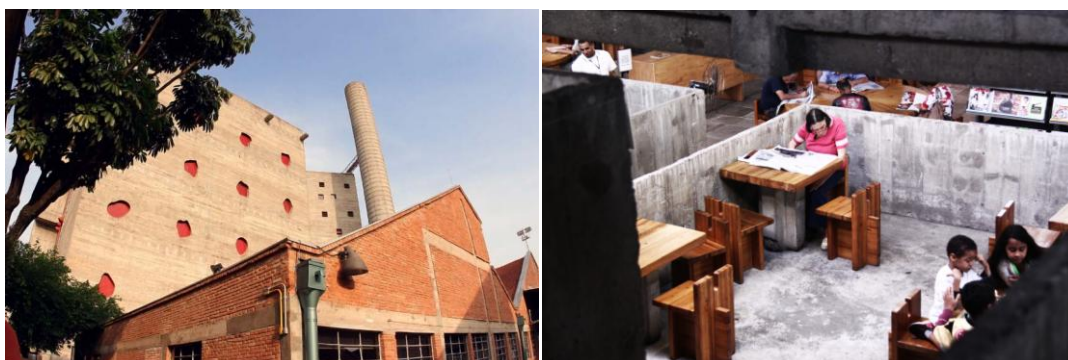
Fig. 3 - SESC Pompeia, 1977 - Centro de Cultura e Lazer, São Paulo. Projecto de Lina Bo Bardi, reabilitação de uma fábrica.
