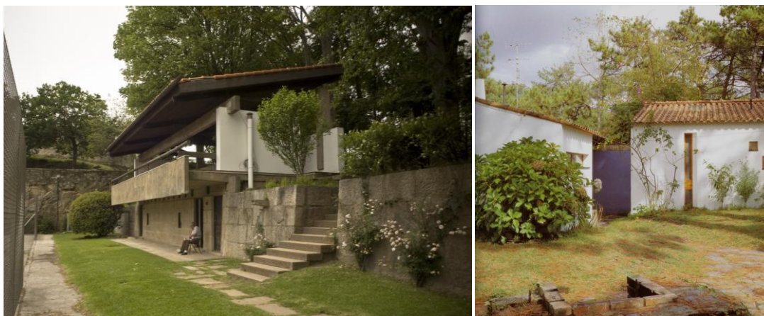
Fig. 5 - Pavilhão de Ténis da Quinta da Conceição - 1956-60 Fernando Távora.
