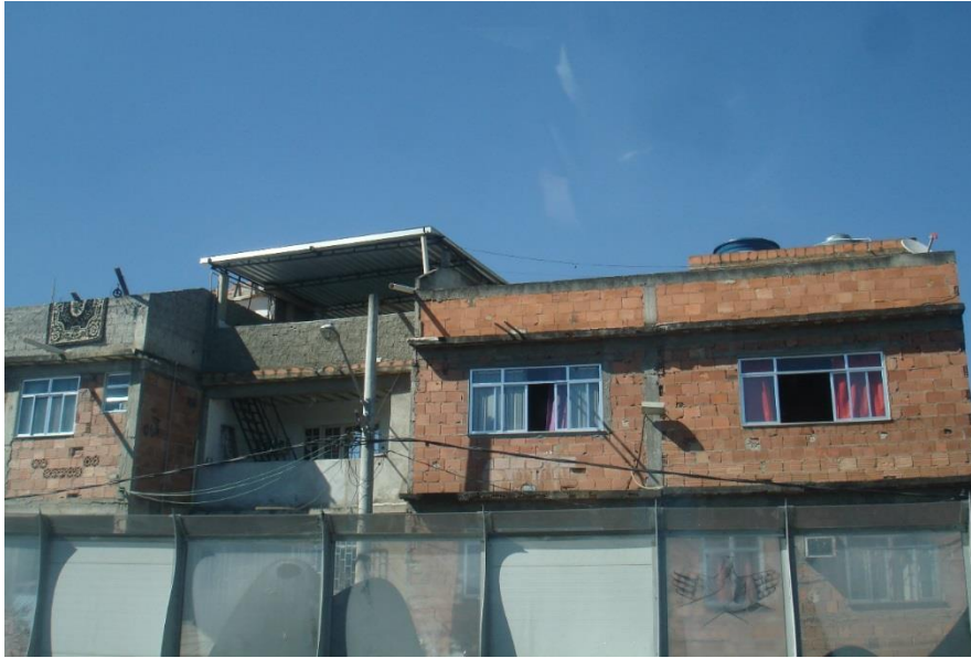
Figura 86 - Construções próximas à via expressa Linha Vermelha
