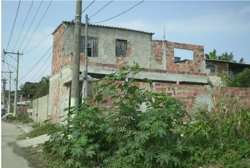
Figura 96 - Exemplo de construção sem janelas
