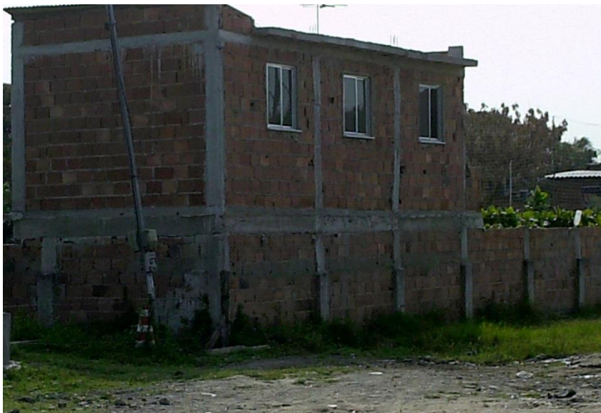
Figura 97 - Outra construção aparentemente inacabada
