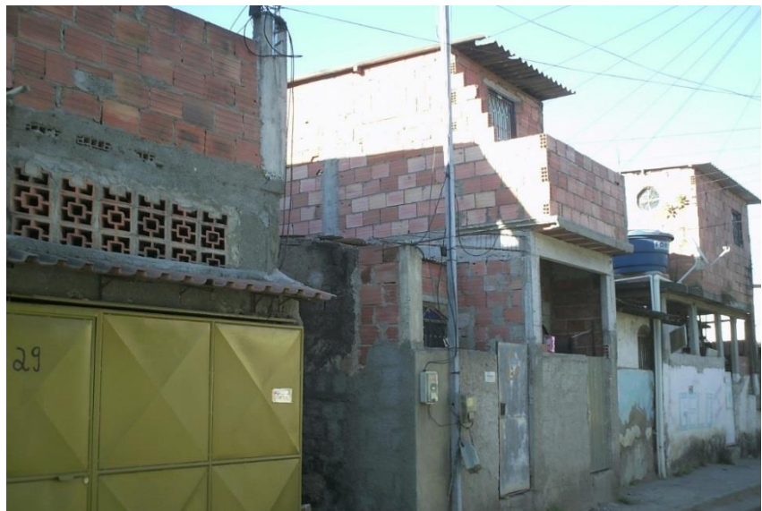
Figura 94 - Construções em tijolo sem revestimento
