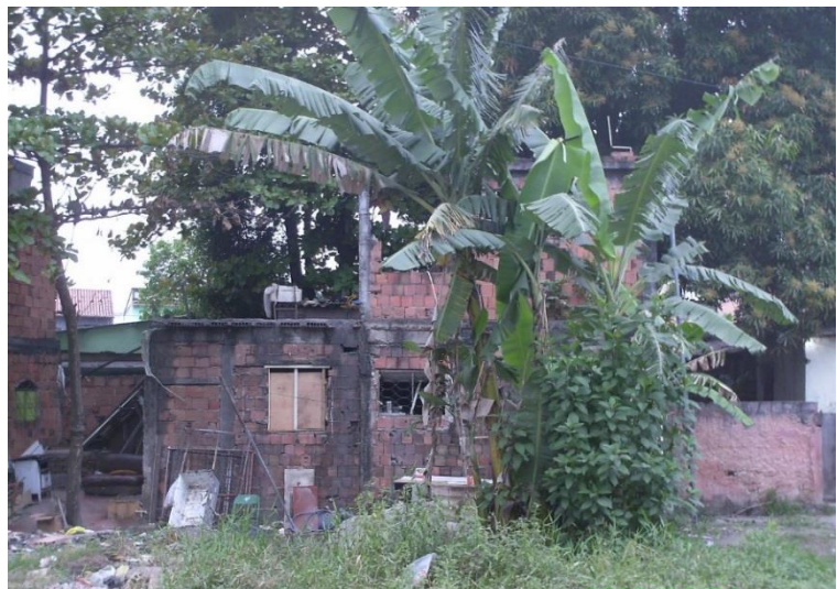
Figura 100 - Construção aparentemente abandonada
