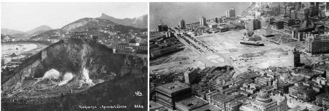
Figura 26 -Desmorte do Morro do Castelo
