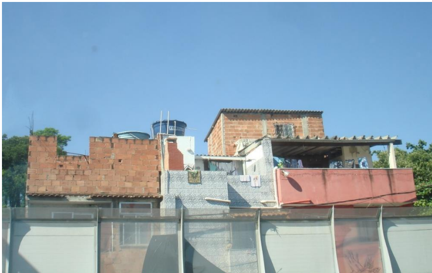
Figura 87 - Construções próximas à via expressa Linha Vermelha
