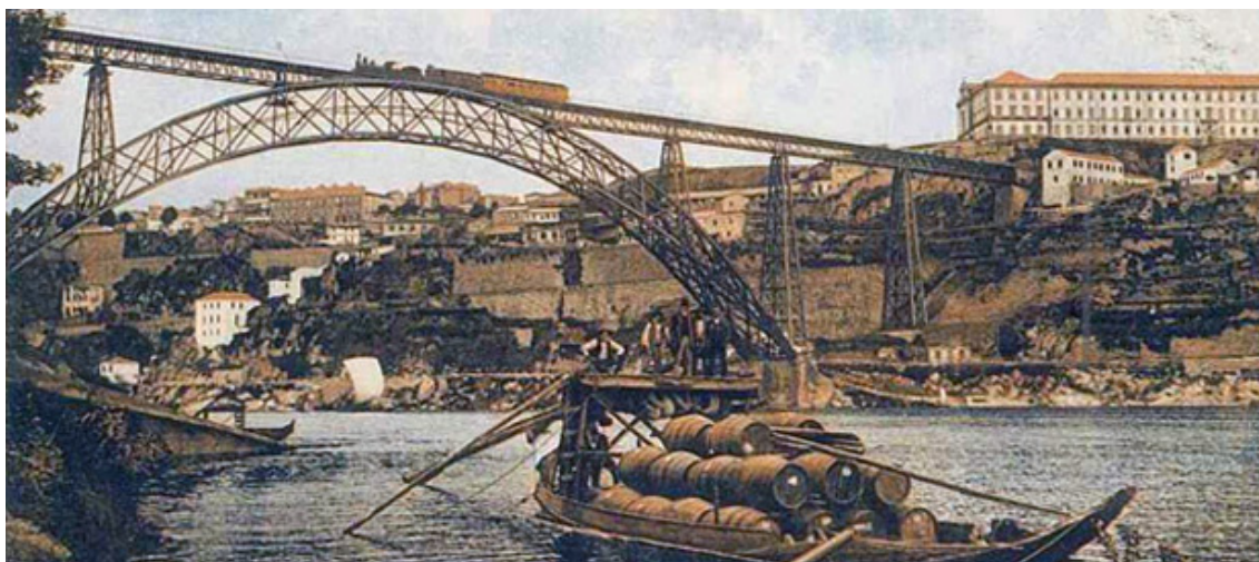
Figura 3.2 - Imagem da Ponte D. Maria Pia, (n.d). Repositório Temático da Universidade do Porto.
