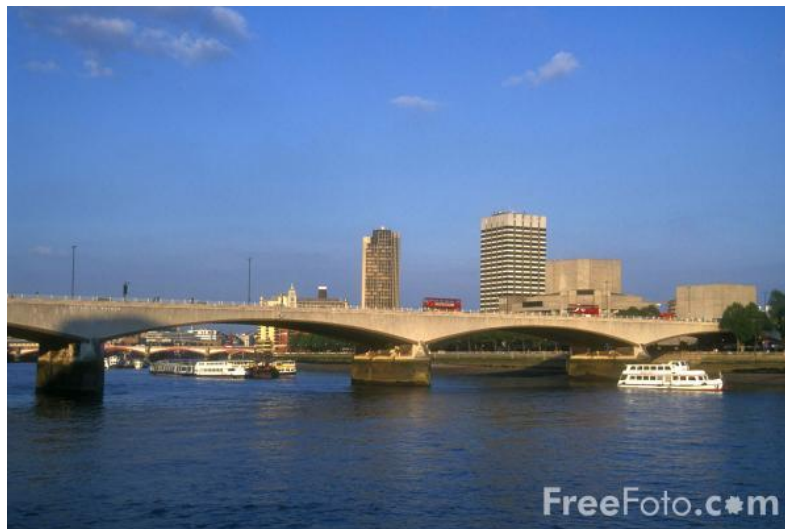
Figura 1.2 (a) - Vista da Ponte de Waterloo [32]
