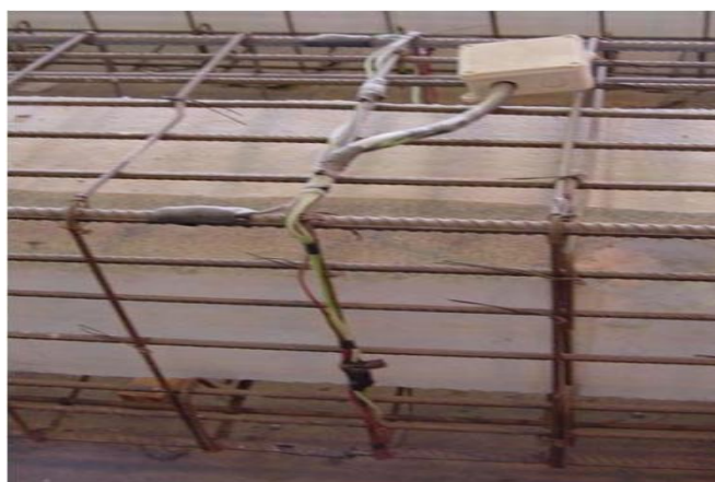
Figura II.8 - Colocação e proteção dos extensómetros em armadura [11]
