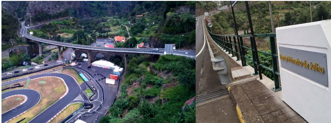
figura 3.23 e 3.24 - à esquerda, vista geral da ponte nova, à direita, detalhe construtivo da ponte Primeiro de Julho
