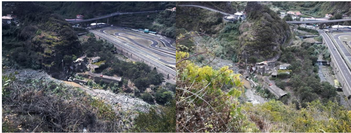
Figura 5.5 e 5.6- à esquerda, o Sítio da Ponte Velha, à direita, o sítio das Grutas
