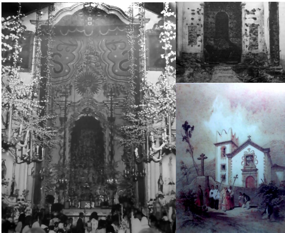
figura 3.1, 3.2 e 3.3- à esquerda, o interior da Igreja antes do incêndio, à direita em cima, a Igreja após o incêndio, à direita em baixo, a ilustração do exterior da antiga Igreja.
