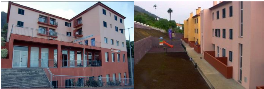
figura 3.10 e 3.11 - à esquerda, o bloco habitacional das Covas visto pelo alçado anterior, à direita, o bloco habitacional das Covas visto pelo alçado posterior, o da rua.
