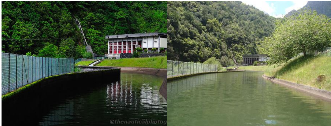
Figura 3.5 e 3.6- à esquerda, foto da Central Hidroelétrica da Fajã da Nogueira, à direita, o reservatório de água para fornecimento da Central
