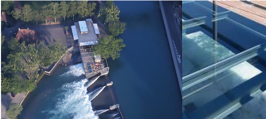
figura 4.3 e 4.4 - à esquerda, a vista aérea do restaurante fluvial, à direita, pormenor de um pavimento com estrutura de aço
