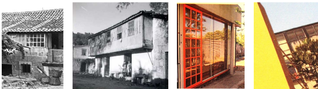
Figs. 93, 94, 95 e 96 - Pormenor de caixilharia de fachada de casa e fachada com varanda envidraçada. Braga arquivo do IAP. Pormenor da caixilharia da casa Manuel Magalhães e pormenor de caixilharia da casa Beires.
