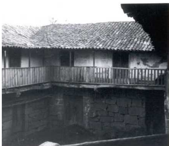
Fig.54 - Conjunto agrícola com pátio interior. Braga. Póvoa do Lanhoso. Covas, 1955.
