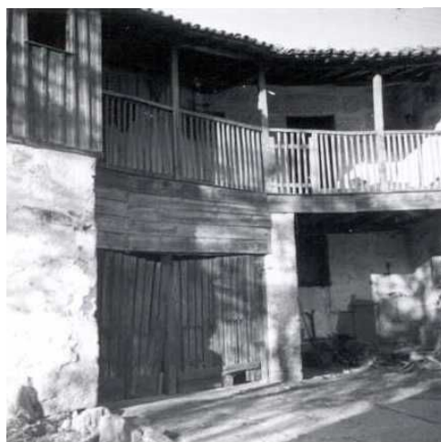
Fig.53- Pormenor de fachada de casa. Braga, Póvoa de Lanhoso, Travassos. Lugar da Correira de Cima.
