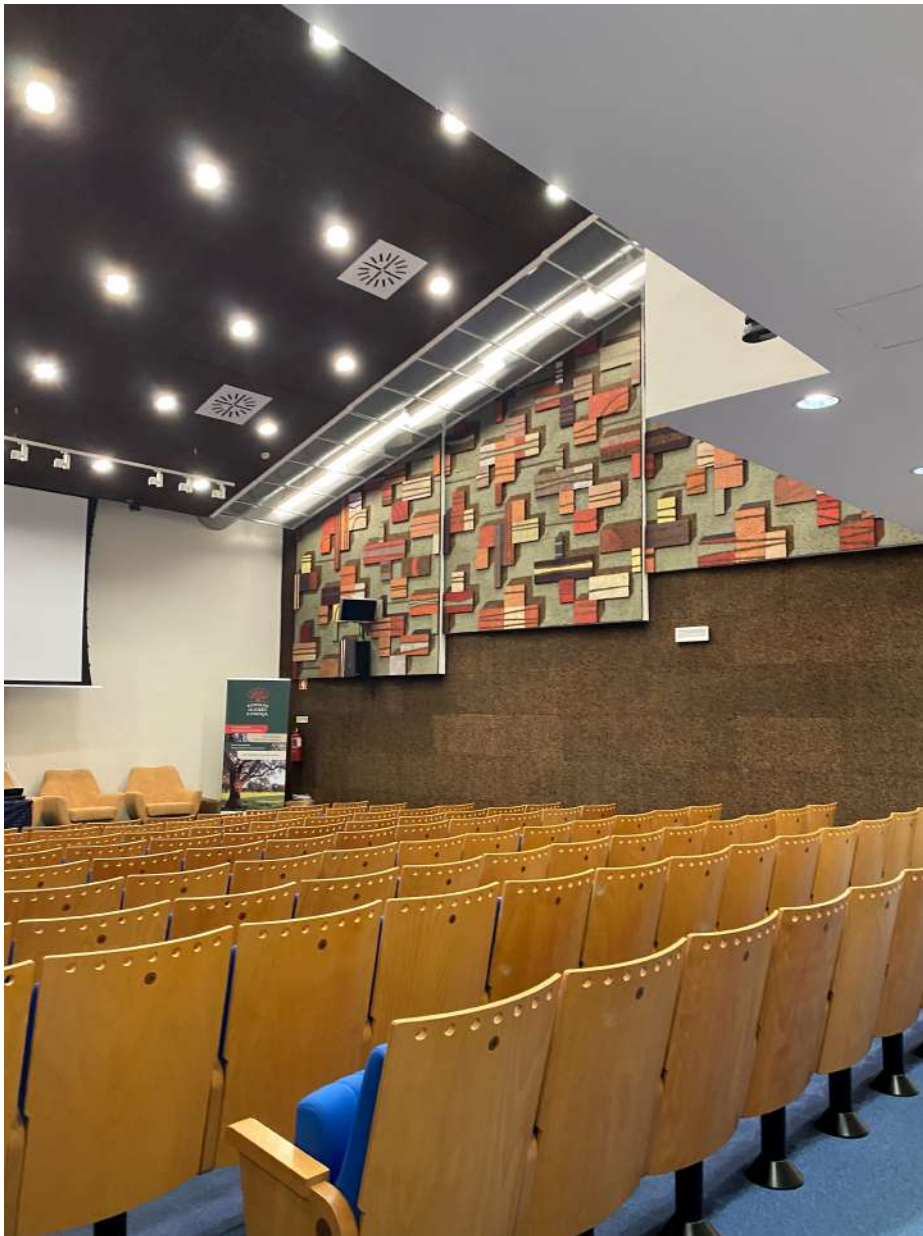
Figura 28 - Auditório do Observatório do Sobreiro e da Cortiça completamente revestido a aglomerado negro. Fonte: Imagem do Autor.
