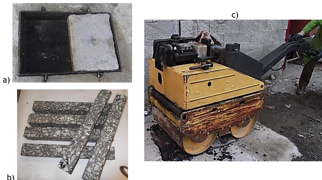
Figura 4.13 - Compactação das lajetas com cilindro de rolos
