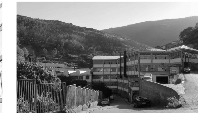
4 _ Img 7 - Fábrica em funcionamento, 2018.
