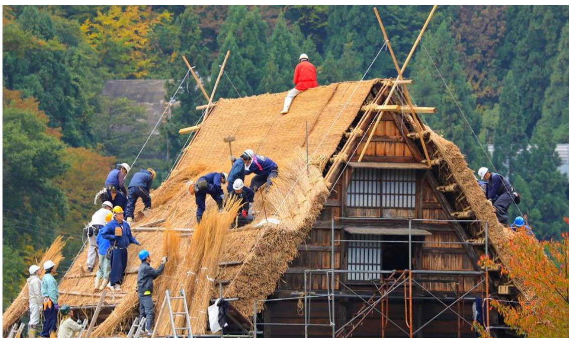
Figura 35 - Substituição da cobertura em Colmo de uma Minka, Shirakawa-go
