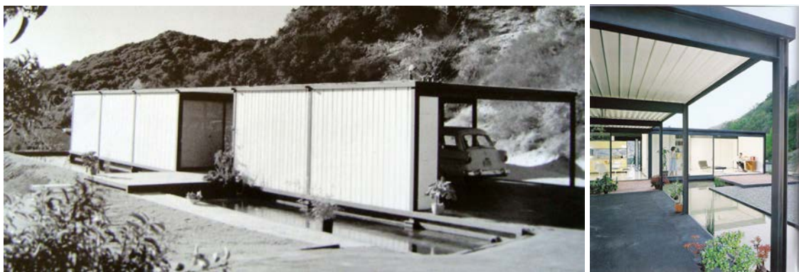
Figura 33 - PIERRE KOENIG, CSH#21, West Hollywood, 1958-1960. (vista exterior)
