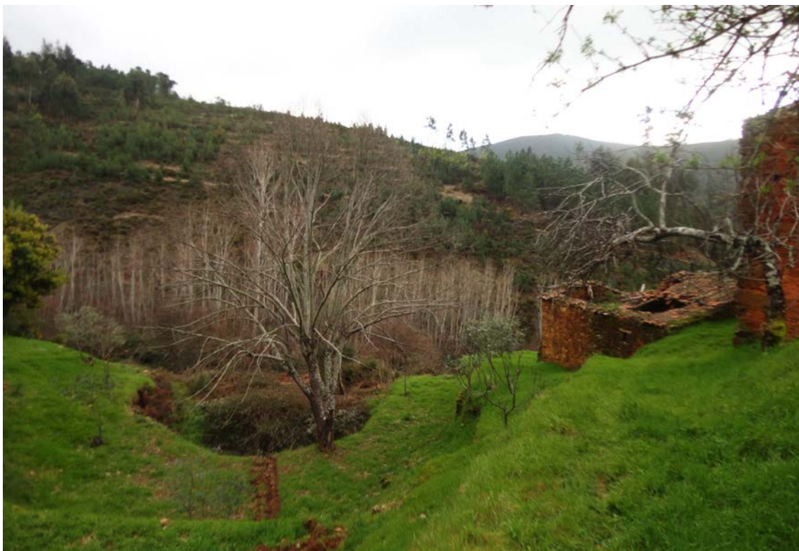
Figura 67 - Envolvente da encosta sul, Porto dos Asnos, Fundão
