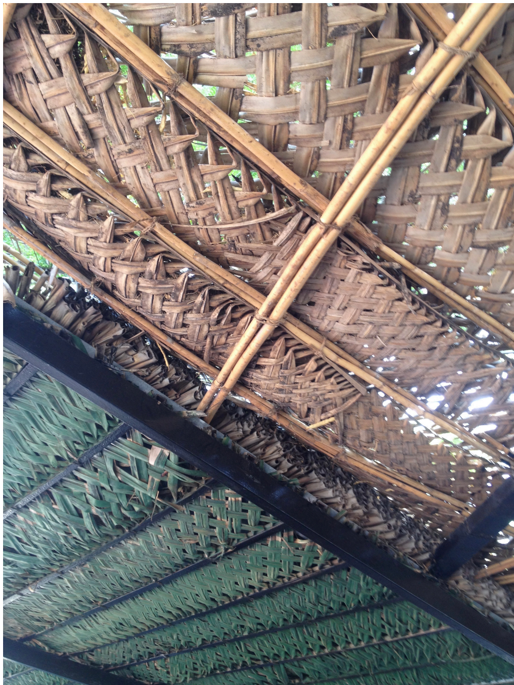
07. Esteira de palmeira estruturada com ripado de cana sacarina. Cidade Velha, Cabo Verde. Fotografia do autor, 2016
