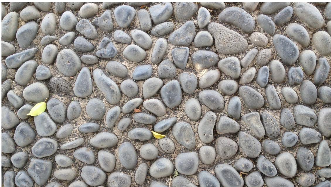
09. Pavimento de basalto. Praia, Cabo Verde. Fotografia do autor, 2016
