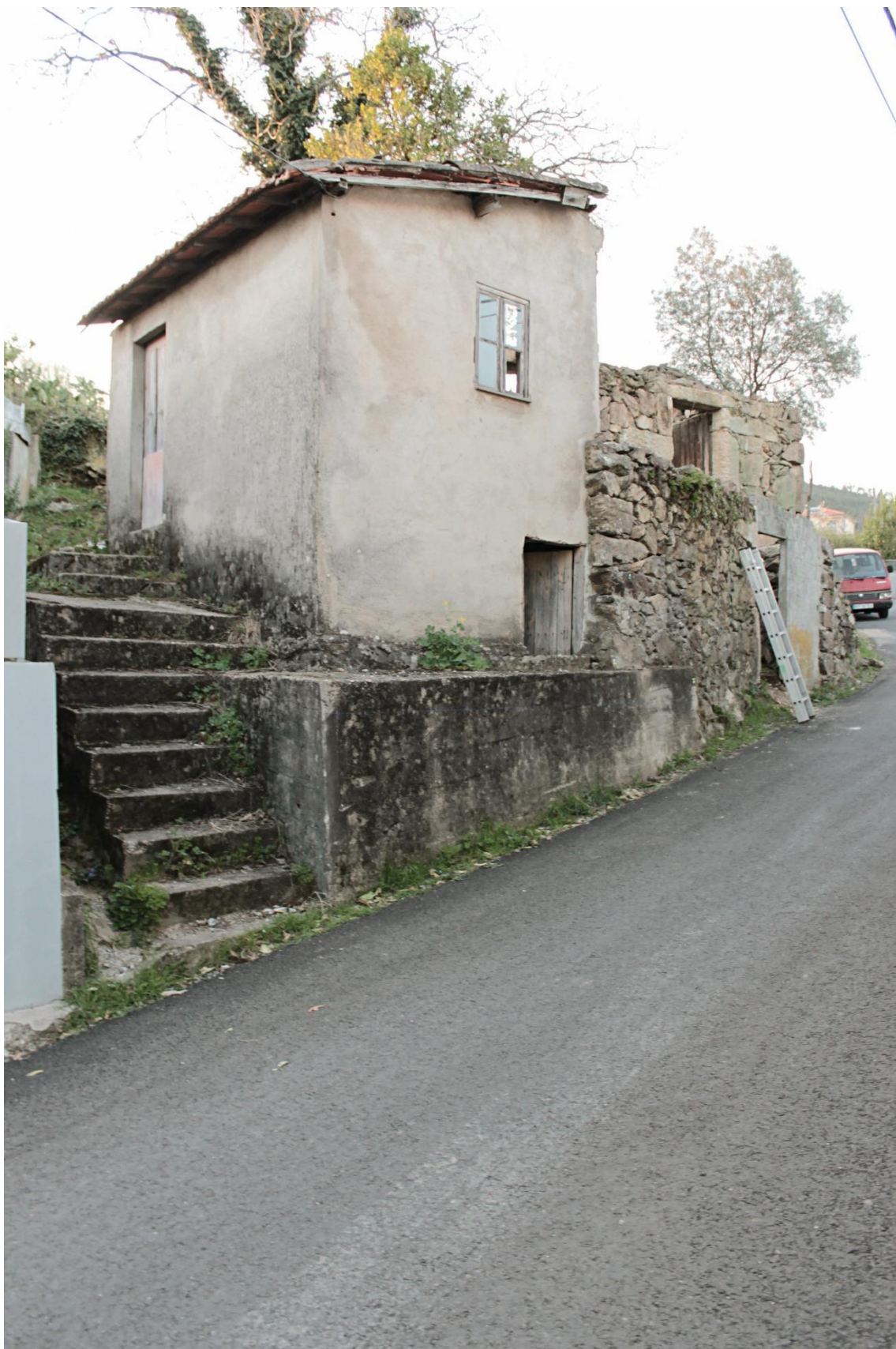
Figura 2.7. - Vista parcial dos alçados Sul e Este do corpo mais recente.
