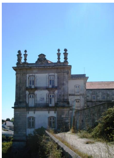
Figura 5 - Vista da ala Este do Convento de Sta. Clara, tirada de Norte
