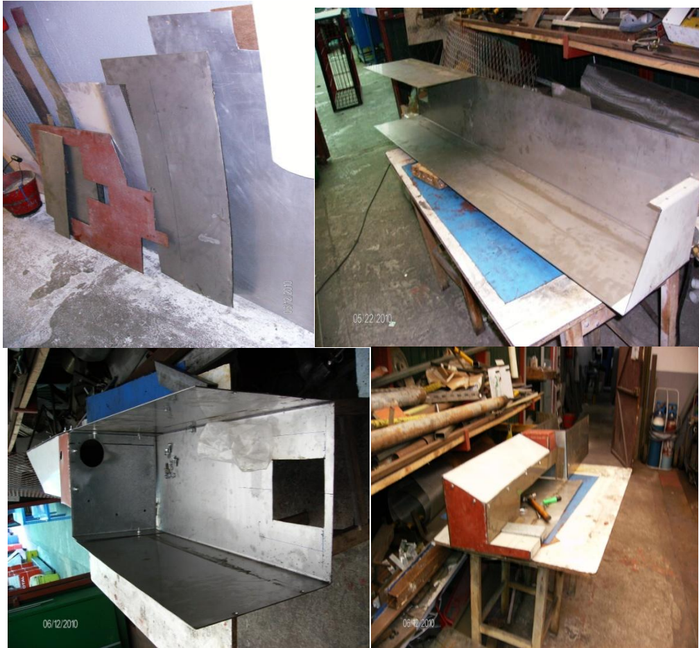
Fig.25- Fases de construção do Banco de Ensaios.
