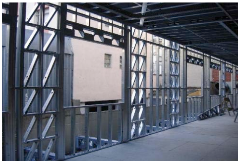
Figura 33 - Hospital Santo Ivo em construção, BH
