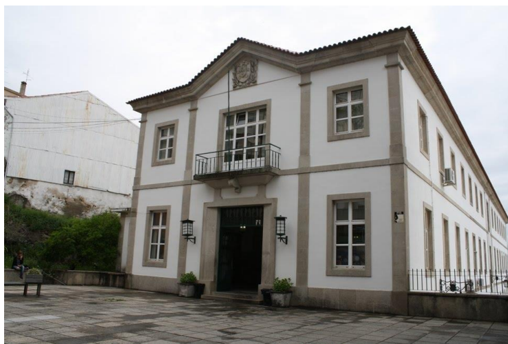
Fig.1 - Fachada da Escola Secundária Campos Melo
