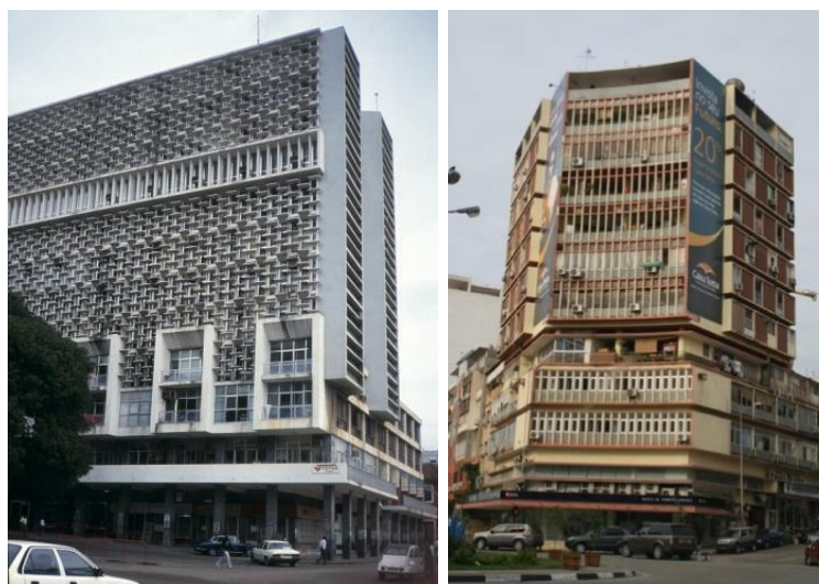
Figura 27- Edifício do Ministério do Urbanismo e Obras Públicas (antigamente Edifício Alfredo Matos) (à esquerda) e edifício localizado no largo Amílcar Cabral Serpa Pinto. Fonte: (HPIP,2021); Google, 2021.
