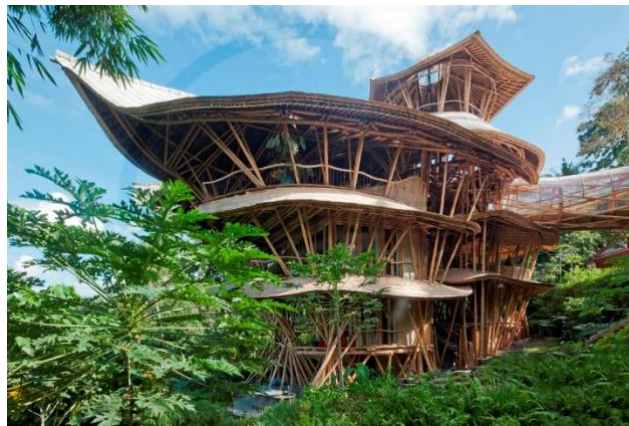
Figura 34- Construção de bambu de uma moradia familiar. Fonte: 2022.
