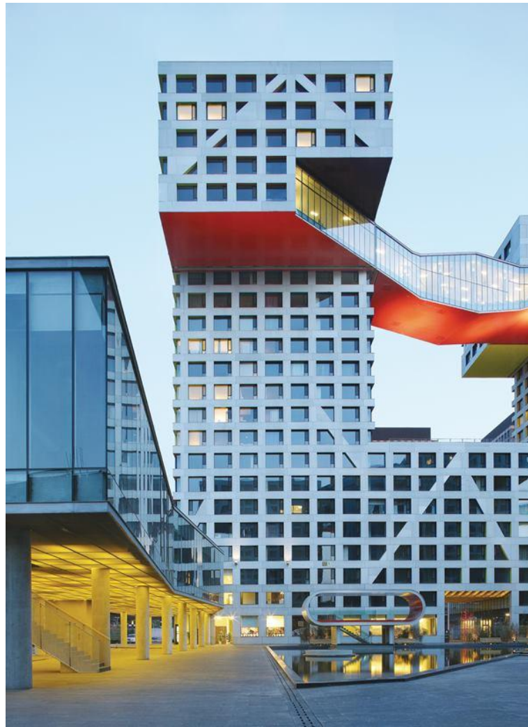
Figura 2.18 - O centro do complexo abre-se a quem o visita, ao mundo. Múltiplos acessos encaminham quem chega: Linked Hybrid , Pequim, China, 2009.
