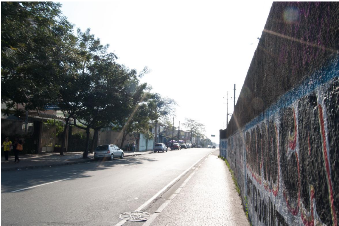
Figura 3.9 - Vista da Rua João Vicente e do Muro de separação da via pública com a linha férrea.
