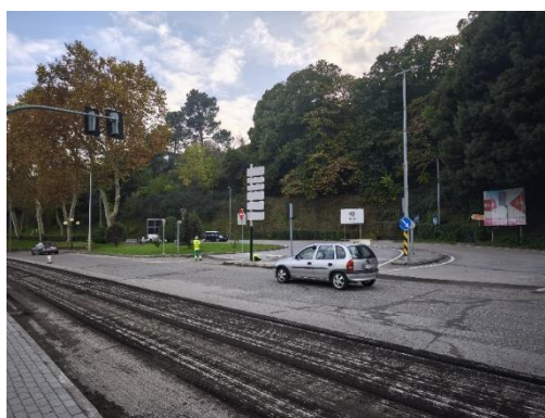
Figura 2 – Fresagem de pavimentos para reutilização, Covilhã
