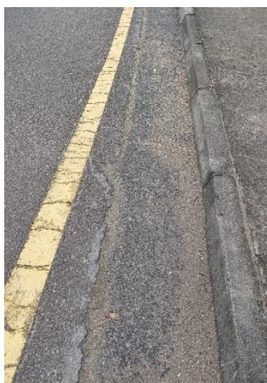
Figura 12 – Vala de infraestruturas
