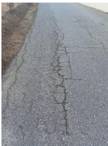
Figura 10 – Abatimento longitudinal da berma
