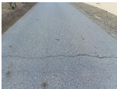
Figura 6- Fissura transversal
