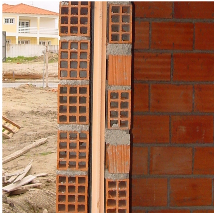
Figura 4.24 - Fotografia do pormenor da parede durante a construção
