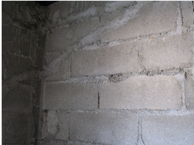
Figura 4.11 - Fotografia da constituição da parede em estudo numa zona sem reboco interior
