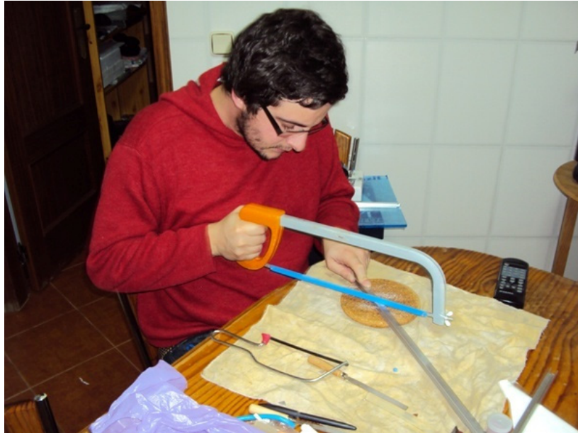
Fig.54 - Corte da calha de alumínio
