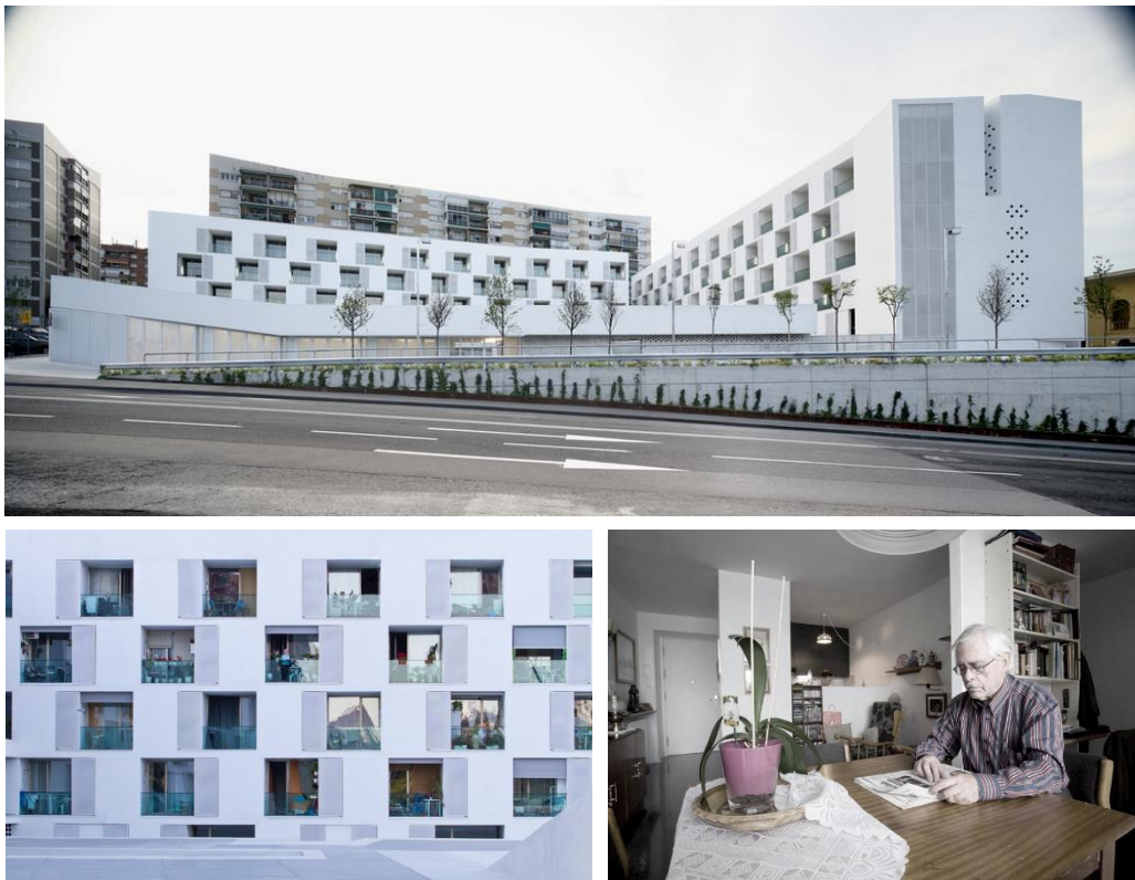
Figura 43a, 43b e 43c - Edifício de habitação para idosos - Barcelona.
