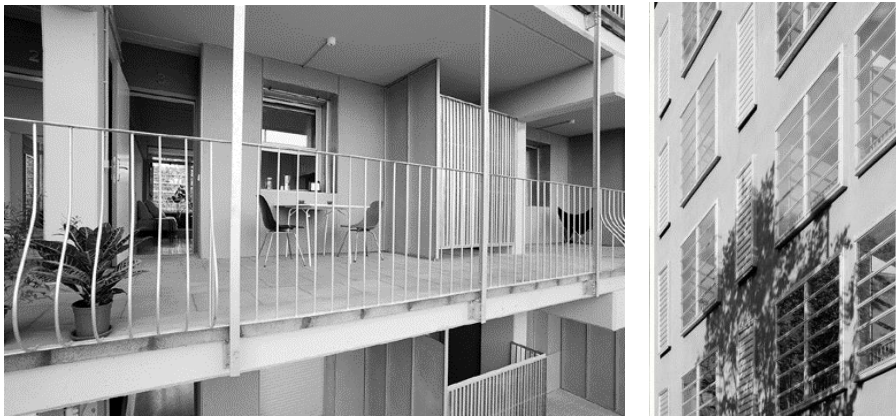
Figura 40a e 40b - A direita, galeria de acesso aos vários pisos e habitações, à esquerda, pormenor dos slats nos vãos.
