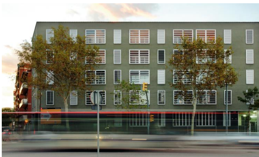
Figura 39 - López Rivera, edifício de habitação social para jovens, Barcelona, 2003-2007 - Fachada Principal.
