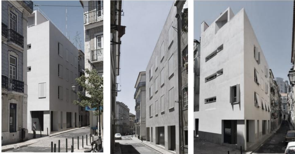
Figura 32a, 32b e 32c - Nuno Távora, Edifício de habitação Social na Rua do Mercado/Rua da Silva, 2005, Lisboa.
