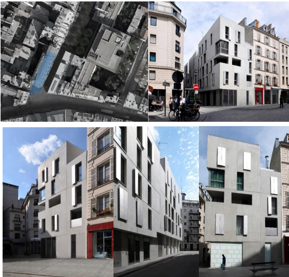
Figura 23a, 23b, 23c, 23d e 23e - Frédéric Schlachet Architecte, Habitação Social em Paris, França, 2012.
