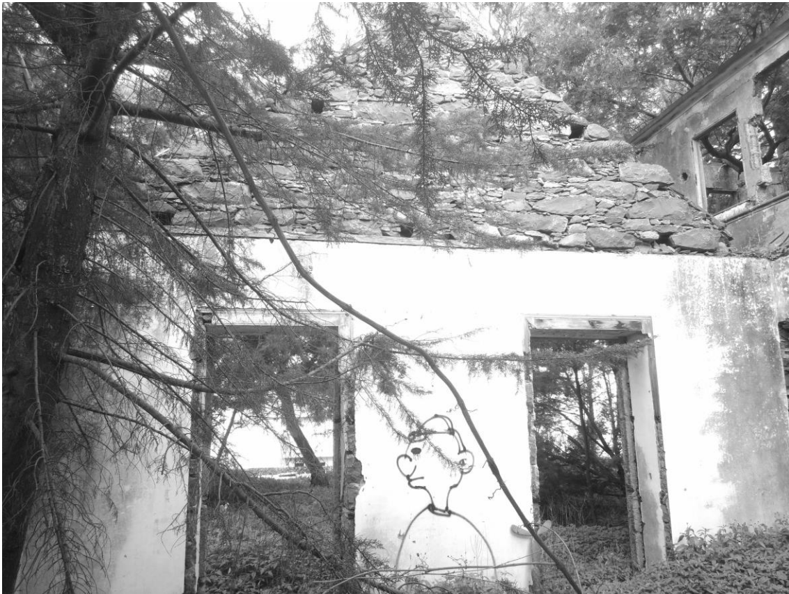
Figura 17: Fotos da ruína. (Foto de autor)
