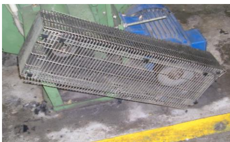
Figura 4.27. Perigos devidamente resguardados.
