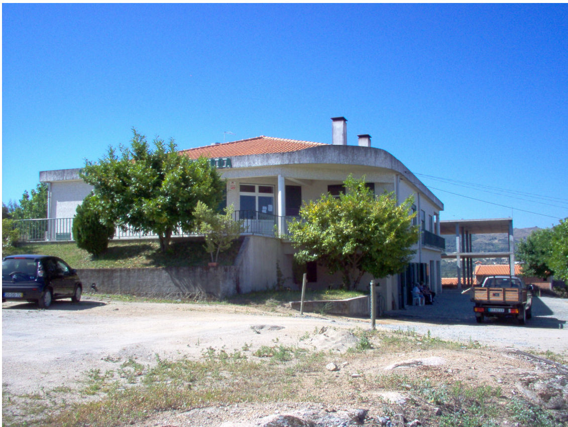
Figura 2.52- Centro Social de Peraboa. O piso inferior tem uma sala de estar para permanência diária dos idosos. Na parte da figura mais à direita encontra-se a estrutura do novo edifício da ampliação do centro social já com dormitórios para a população idosa.
