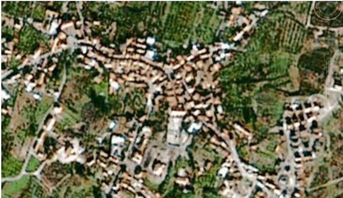
Figura 2.8- Os edifícios mais antigos de Peraboa ladeiam a via que atravessa a aldeia. São construções de características predominantemente vernaculares que se vão encostando umas às outras e formam um troço sinuoso. No entanto no canto inferior direito temos um conjunto de moradias unifamiliares mais recentes isoladas da via de tráfego e onde já existe implantação de traçado ortogonal.
