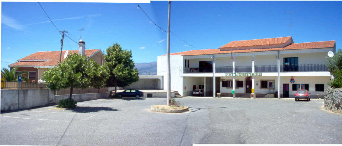
Figura 2.54- Edifício da Junta de Freguesia de Peraboa. No piso térreo do lado direito há um jardim-de-infância. Do lado esquerdo observa-se um palco onde têm lugar as festividades da aldeia.
