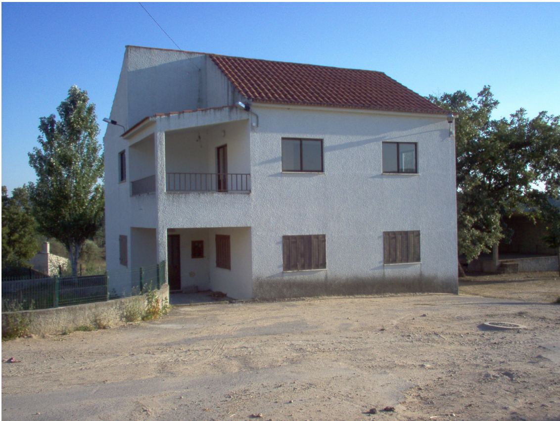
Figura 2.55- Casa do Povo de Castanheiras de Baixo. O edifício encontra-se sem uso.
