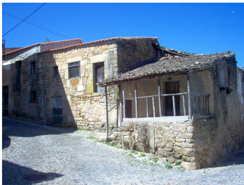
Figura 2.37- Velhas construções dentro da aldeia. A homogeneidade do conjunto é conseguida pela utilização dos mesmos materiais e morfologia. A pequena escala é predominante.
