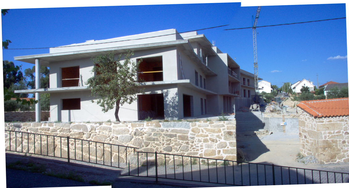
Figura 2.53- Residência sénior em construção com conclusão prevista para 2009 (aldeia de Peraboa). Este edifício será um lugar de residência para as pessoas mais idosas da aldeia para além do Centro Social de Peraboa.
