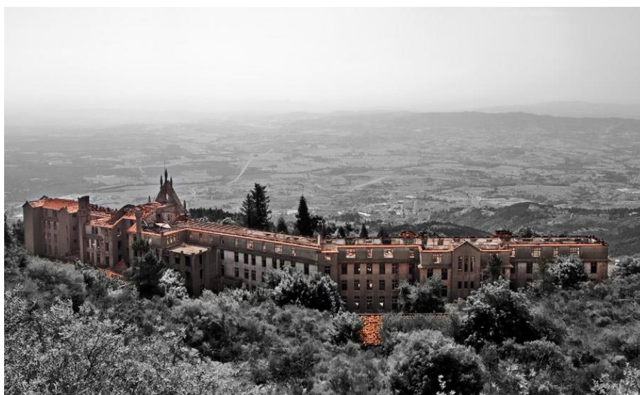
Figura 2 - Sanatório dos Ferroviários _ Fonte: (Reis, 2010)
