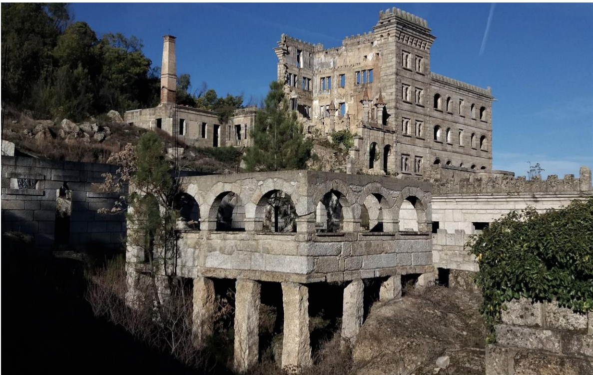
Figura 30 - Elemento preexistente_Fonte: Autora
