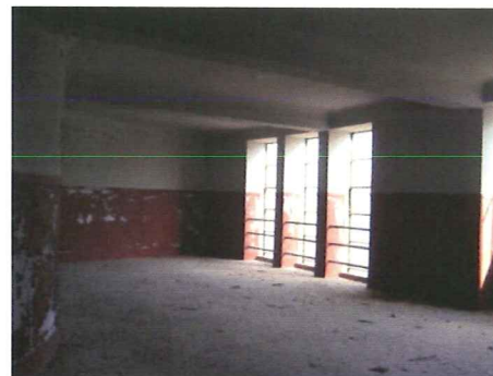
Fig.135 - Cine-Teatro da Guarda. Fotografia do corredor do 2º balcão. Localização na planta a azul. Imagem do autor. Março de 2011.
