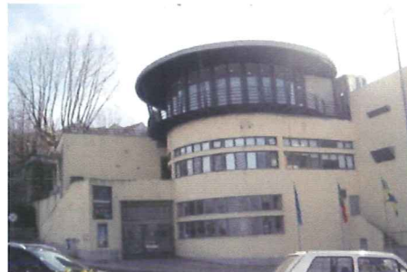
Fig. 67 - Cine-Teatro Jardim da Casa Municipal da Cultura de Seia. Fachada curva voltada a nascente. Evidência da construção em metal preto e vidro.
