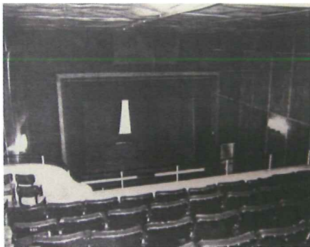
Fig. 54 - Cine-Teatro S. Luís. Boca de cena demolida. Aspecto até 1997.
