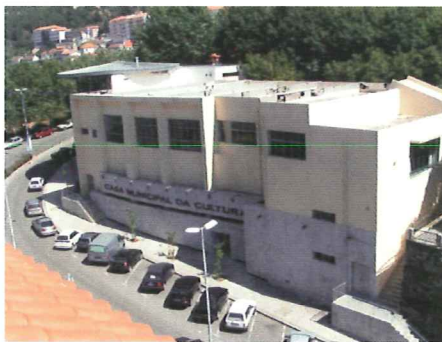
Fig. 64 - Cine-Teatro Jardim da Casa Municipal da Cultura de Seia. Fachada voltada a Norte. Contraste entre a ampliação e o existente revestido a pedra.
