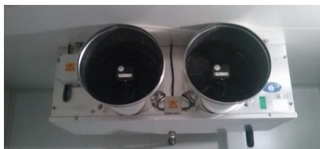
Figura 8 - Imagem das entradas de ar no interior da câmara.
