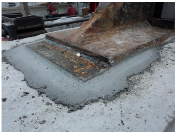
Figura 54 - Pormenor da reparação com grout e da chapa de confinamento
