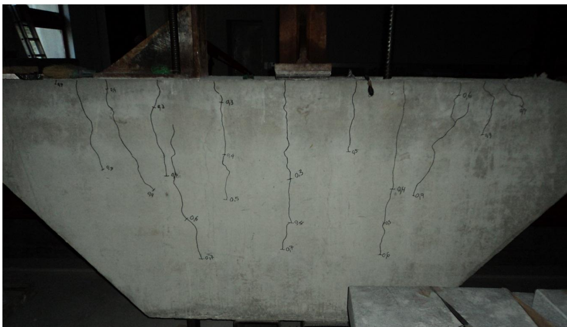
Figura 71 - Fissuração da peça de betão armado (1º ensaio)
