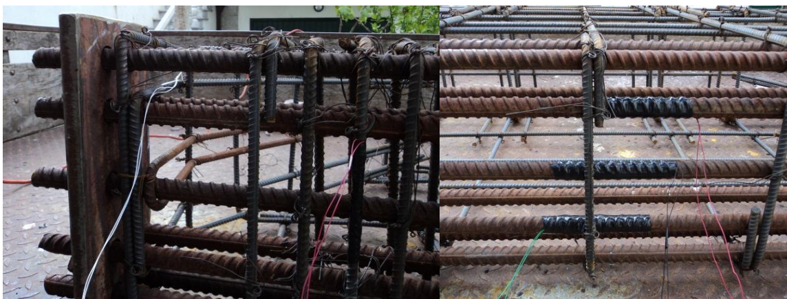
Figura 49 - Pormenores da colocação dos extensómetros no betão
