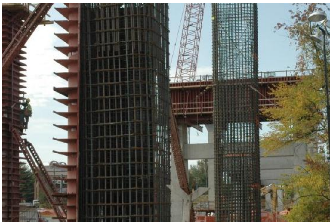
Figura 10 – Pormenor das armaduras existentes num pilar em betão armado (Dulles Corridor Metrorail Project por John R Cambron 2010)
