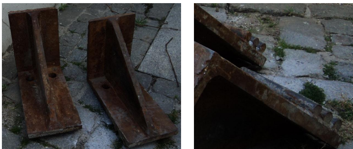
Figura 44 - Consolas metálicas (perspectiva à esquerda, pormenor das barras soldadas à direita)
