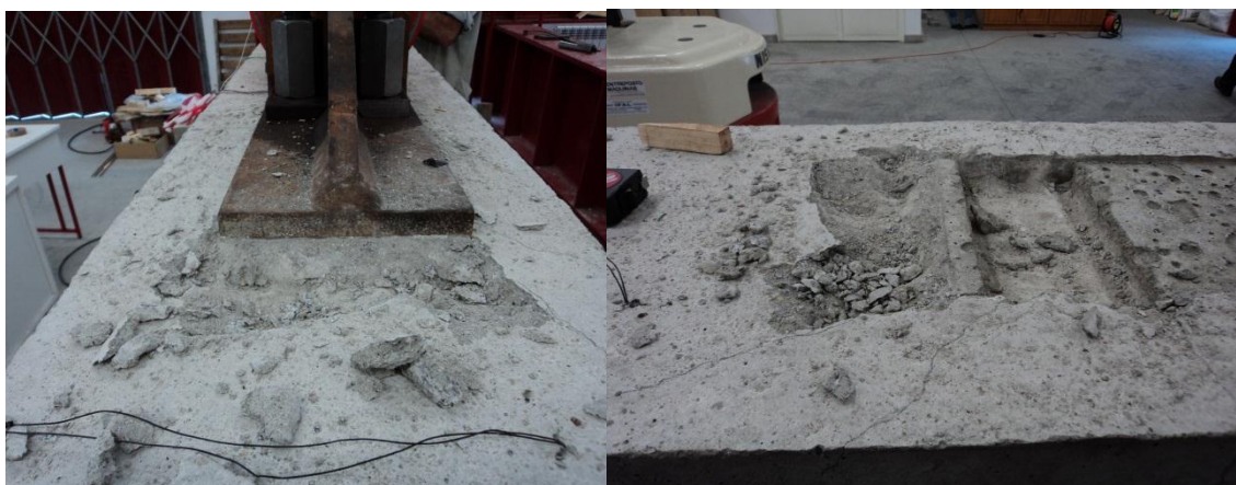
Figura 73 - Rotura da ligação por destacamento parcial da zona não confinada junto à base da peça
